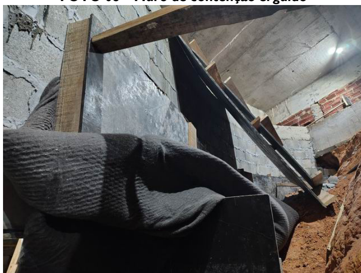
FOTO 09 – Muro de contenção erguido e com drenagem adequada
