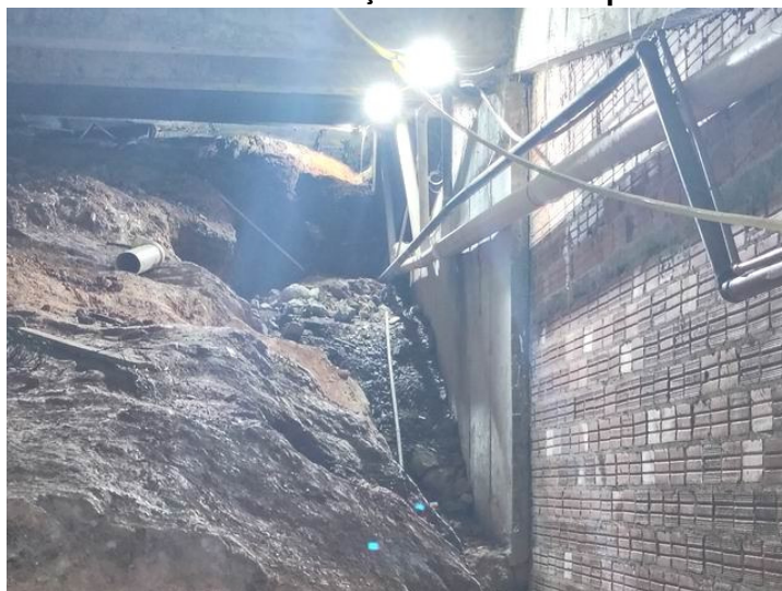
FOTO 32 – Tubulações sendo readequadas
