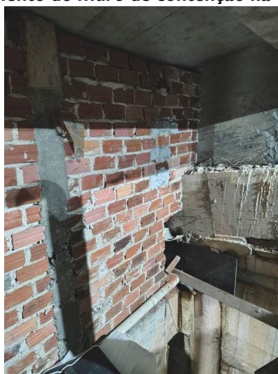
FOTO 23 – Parede de divisa com o subsolo a ser revestida
