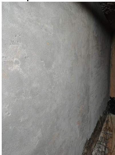
FOTO 06 – Parede de divisa já revestida
