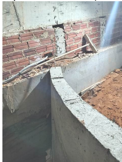
FOTO 17 – Encontro do muro de contenção com divisa esquerda
