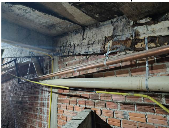
FOTO 30 – Tubulações sendo readequadas
