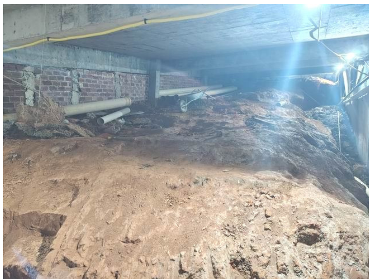
FOTO 40 – Vista geral do talude
