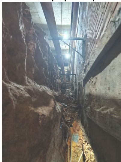
FOTO 12 – Lateral do talude com tubulações parcialmente ajustadas e erosão contida
