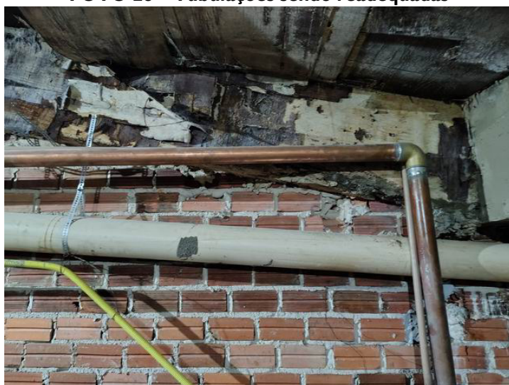
FOTO 29 – Tubulações sendo readequadas
