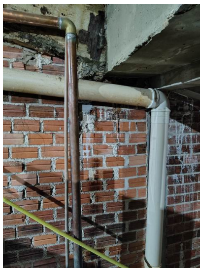
FOTO 28 – Tubulações sendo readequadas
