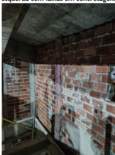
FOTO 21 – Parede de divisa com o subsolo a ser revestida
