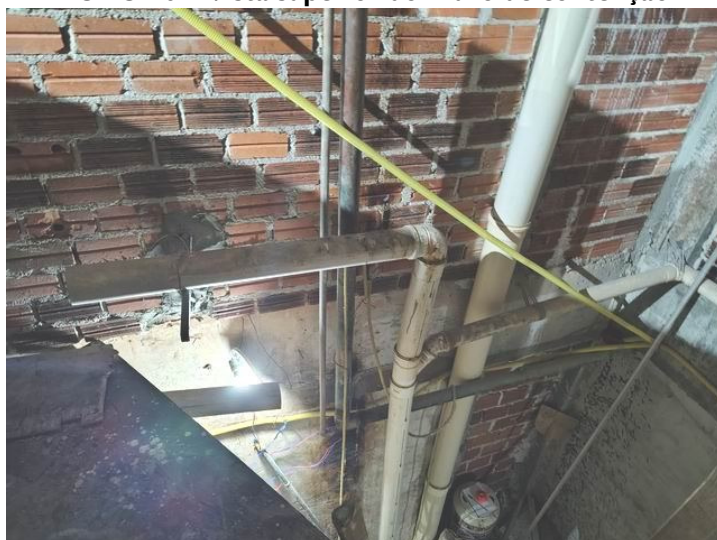
FOTO 27 – Tubulações sendo readequadas
