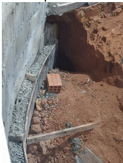
FOTO 26 – Vista superior do muro de contenção
