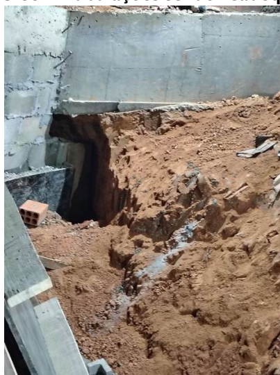
FOTO 36 – Porção de encontro do talude com o muro de contenção
