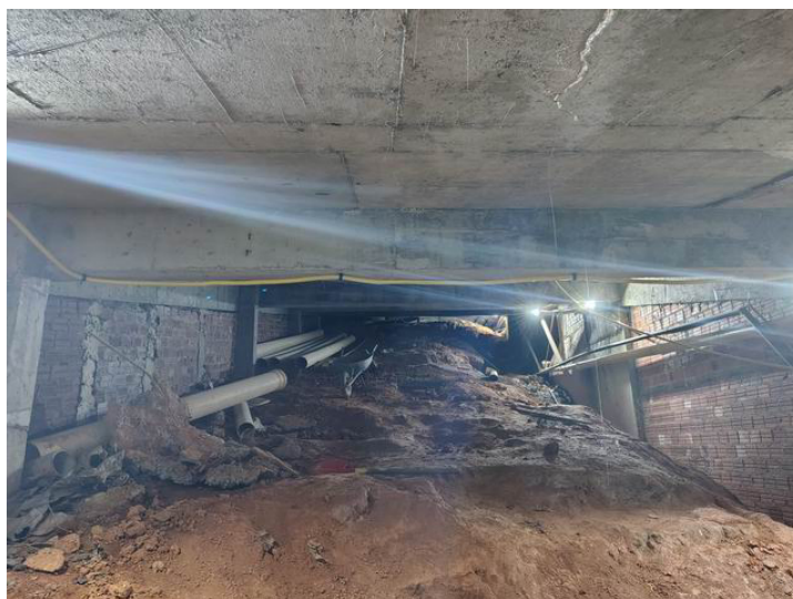
FOTO 19 – Vista geral do talude sob a rampa
