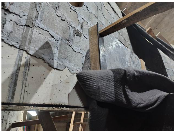
FOTO 07 – Muro de contenção erguido
