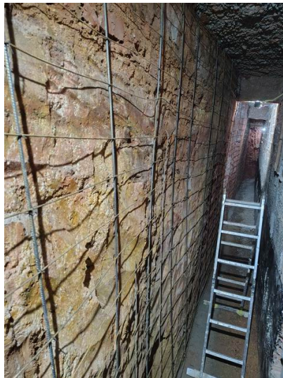
FOTO 02 – Contenção do talude sendo realizado atrás da Sala do Arquivo Inativo
