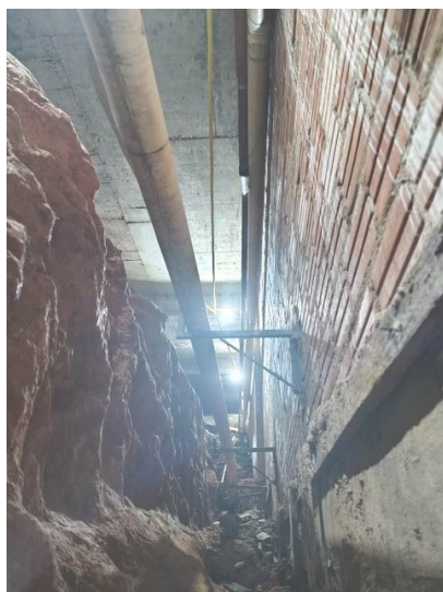
FOTO 13 – Lateral do talude com tubulações parcialmente ajustadas e erosão contida
