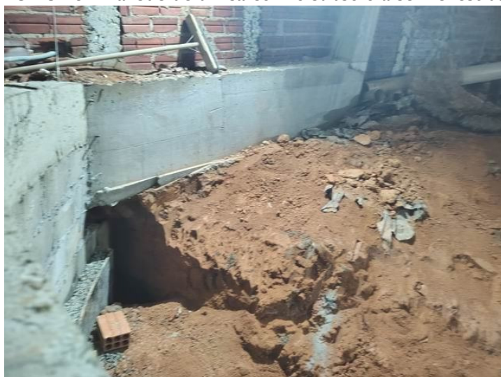
FOTO 24 – Vista superior do muro de contenção
