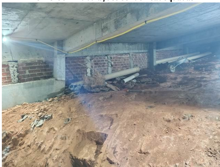
FOTO 39 – Vista geral do talude
