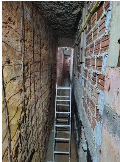
FOTO 01 – Contenção do talude sendo realizado atrás da Sala do Arquivo Inativo
