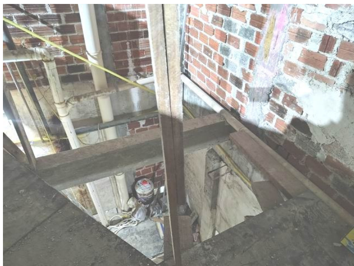
FOTO 22 – Travamento do muro de contenção na estrutura do edifício
