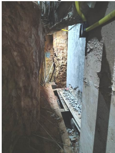
FOTO 11 – Lateral do talude sendo preparada para receber contenção lateral
