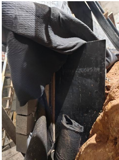
FOTO 10 – Saída da drenagem do muro de contenção
