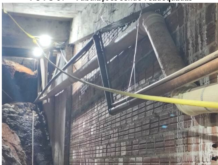
FOTO 38 – Tubulações sendo readequadas
