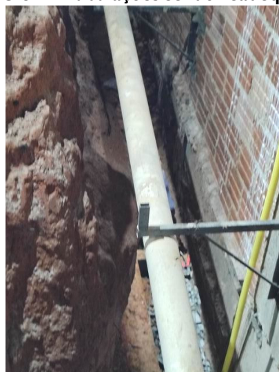
FOTO 33 – Tubulações sendo readequadas
