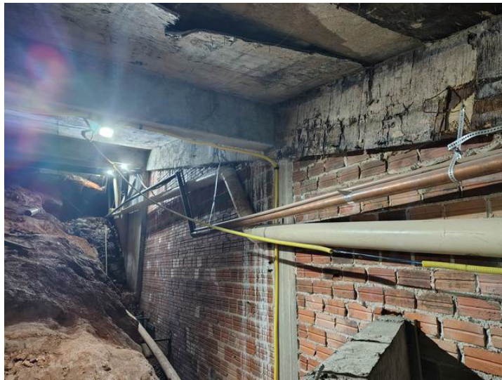
FOTO 31 – Tubulações sendo readequadas
