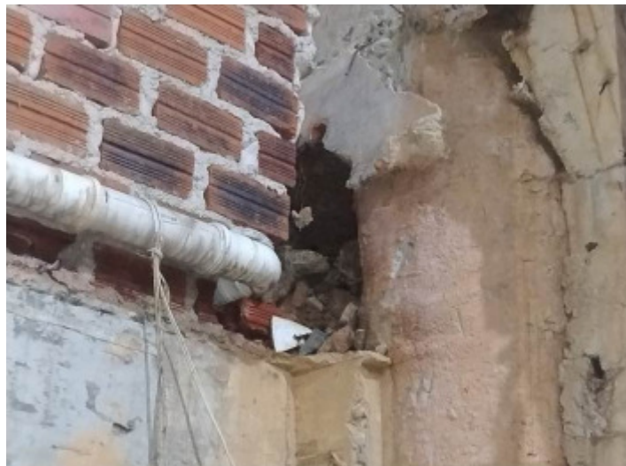
Vazio existente junto à contenção
