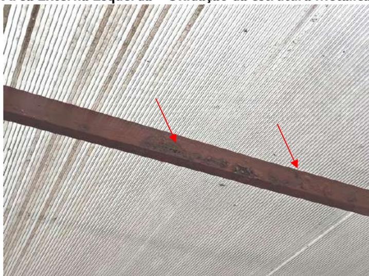
**FOTO 242 – Área Externa Esquerda – Oxidação da estrutura metálica de cobertura**
