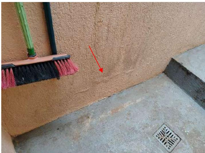
**FOTO 274 – Lavanderia – Área externa – Infiltração de umidade no muro esquerdo**
