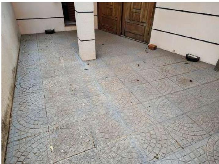
**FOTO 256 – Área Externa Esquerda – Deterioração das placas cimentícias do piso**
