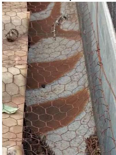
**FOTO 309 – Cobertura Auditório – Oxidação das calhas e acúmulo de sujeiras**
