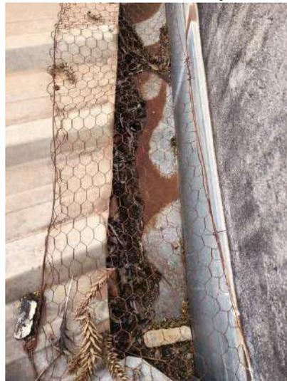
**FOTO 308 – Cobertura Auditório – Oxidação das calhas e acúmulo de sujeiras**
