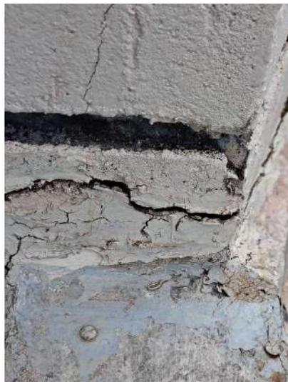
**FOTO 301 – Cobertura – Descolamento do rufo metálico e ausência de vedação**
