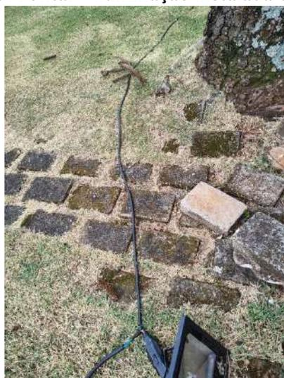
**FOTO 176 – Área Frontal – Iluminação instalada com fiação exposta**
