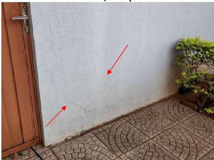
**FOTO 63 – Fachada Frontal – Fissuras e deterioração generalizada da pintura**
