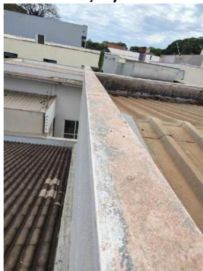
**FOTO 291 – Cobertura – Rufos com a pintura deteriorada**
