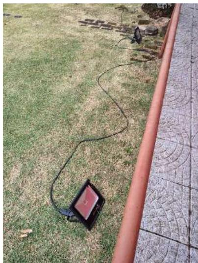
**FOTO 175 – Área Frontal – Iluminação instalada com fiação exposta**
