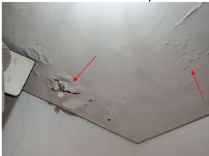
**FOTO 264 – Lavanderia – Deterioração completa do forro de gesso**
