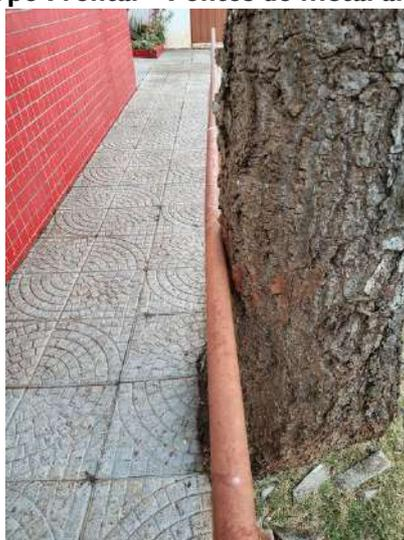
**FOTO 68 – Guarda-Corpo Frontal – Desalinhamento causado pela árvore ao lado**
