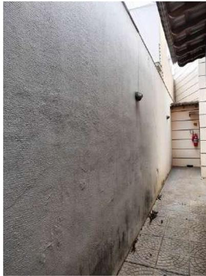
**FOTO 253 – Muro Esquerdo – Deterioração generalizada da pintura e fissuras**
