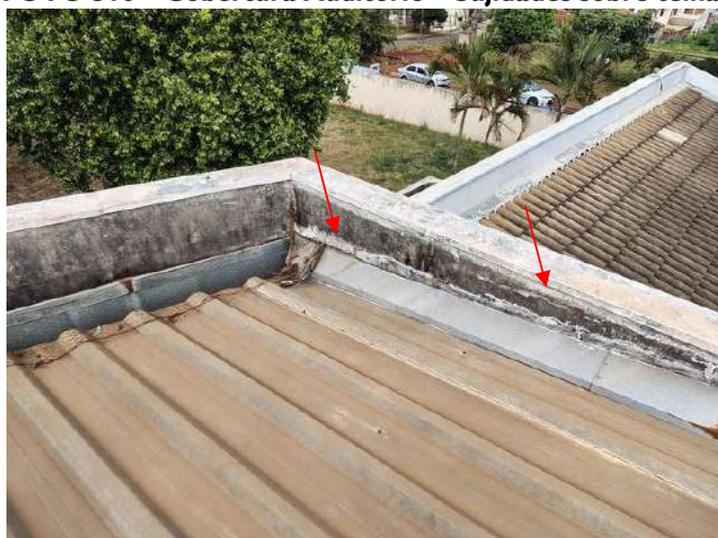
**FOTO 317 – Cobertura Auditório – Descolamentos de emboço das platibandas**
