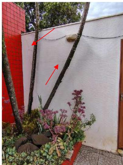
**FOTO 40 – Muro Direito Frontal - Deterioração generalizada da pintura e fissuras**
