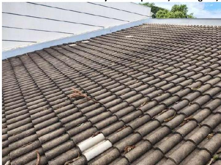
**FOTO 287 – Cobertura – Telhas com sujidades e presença de vegetação em excesso**
