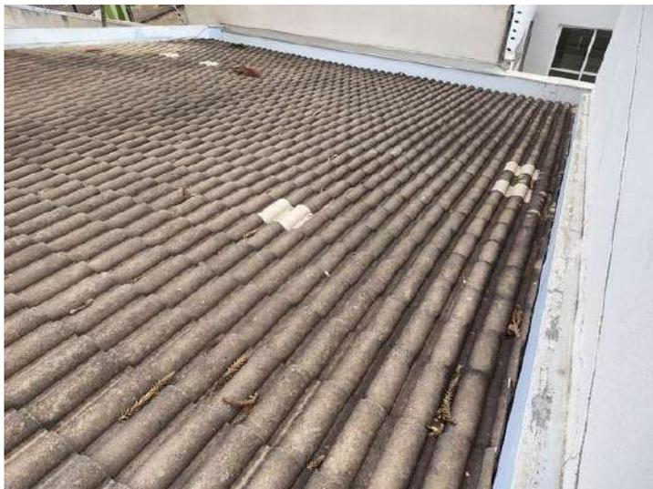
**FOTO 304 – Cobertura – Telhas com sujidades e presença de vegetação em excesso**
