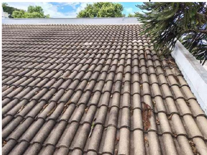
**FOTO 285 – Cobertura – Telhas com sujidades e presença de vegetação em excesso**
