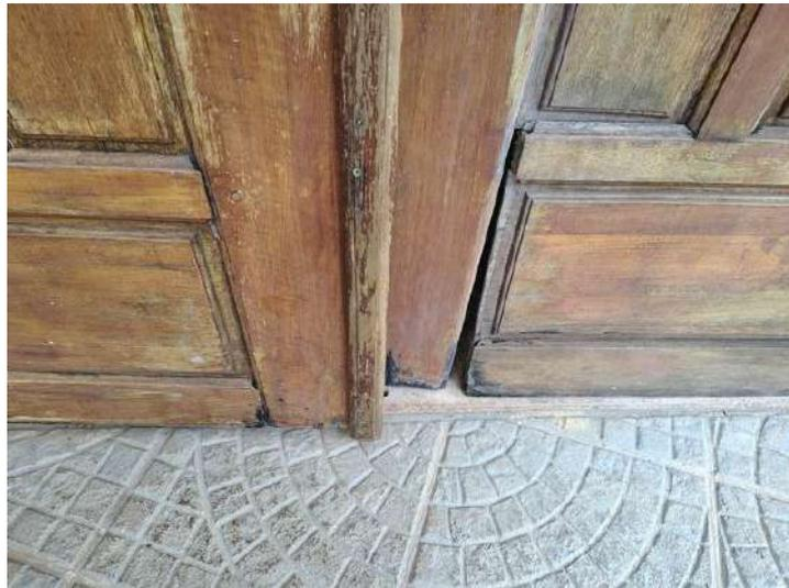
**FOTO 244 – Auditório – Deterioração avançada da porta de saída**
