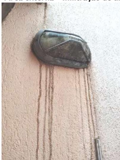
**FOTO 275 – Lavanderia – Área externa – Luminária deteriorada e causando sujidades no muro**
