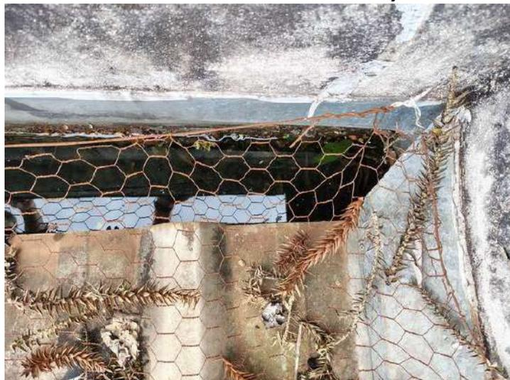
**FOTO 339 – Cobertura Auditório – Acúmulo de água em calha**
