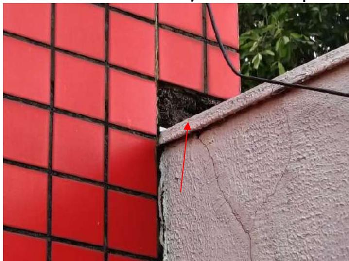
**FOTO 44 – Fachada Frontal – Ausência de pastilhas junto ao muro direito**
