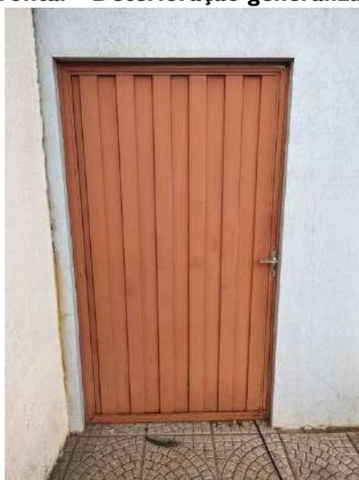
**FOTO 59 – Fachada Frontal – Porta de acesso lateral esquerdo com pontos de oxidação**
