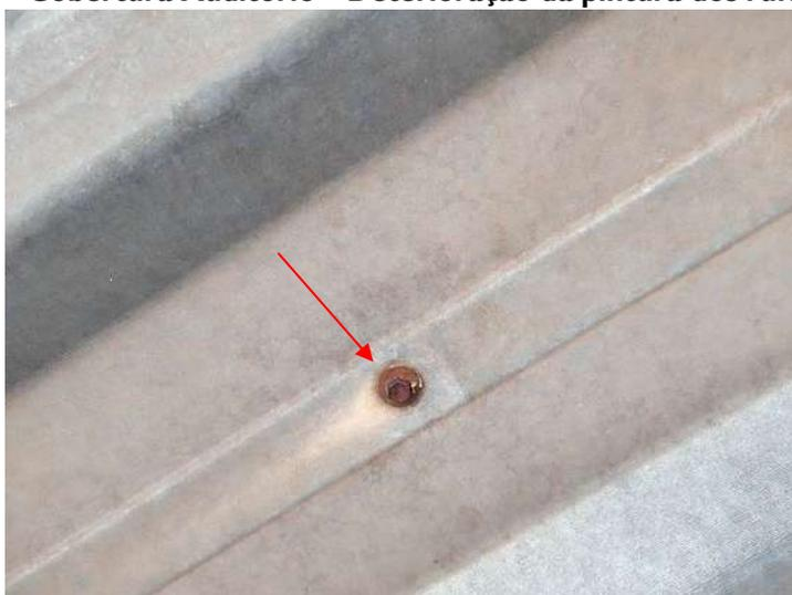
**FOTO 329 – Cobertura Auditório – Oxidação de parafuso**
