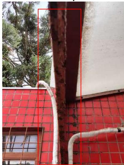
**FOTO 48 – Fachada Frontal – Perda de rejuntamento entre pastilhas cerâmicas e oxidação da estrutura da cobertura**
