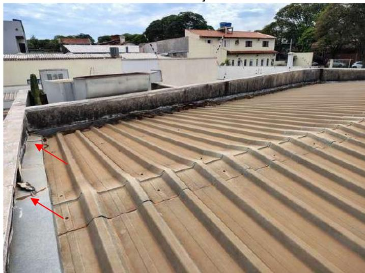
**FOTO 312 – Cobertura Auditório – Oxidação de rufo metálico e sujidades sobre telhas**
