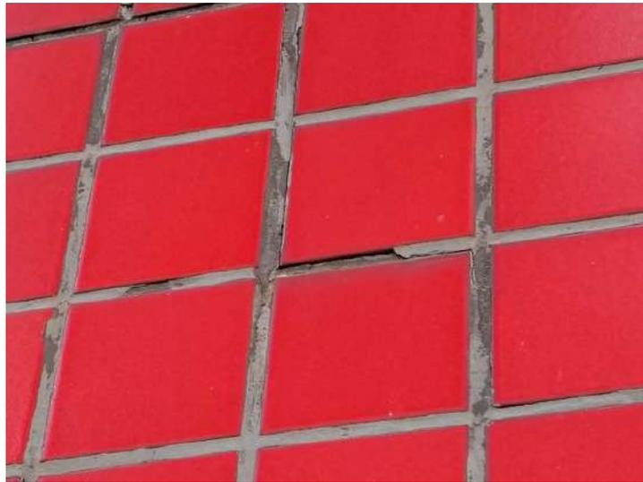
**FOTO 52 – Fachada Frontal – Perda do rejuntamento entre pastilhas cerâmicas**
