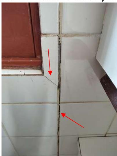
**FOTO 107 – Copa – Trinca em cerâmica e entre rejuntas, lado direito da janela**
