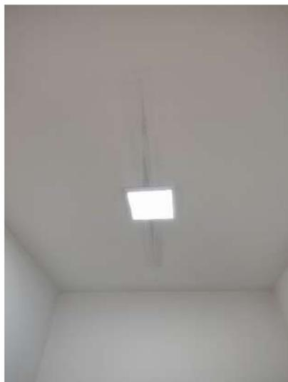
**FOTO 118 – Recepção – Falha na pintura do teto**
