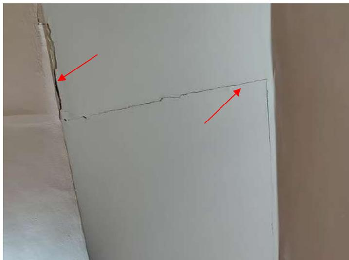
**FOTO 208 – Auditório – Deterioração generalizada do forro**
