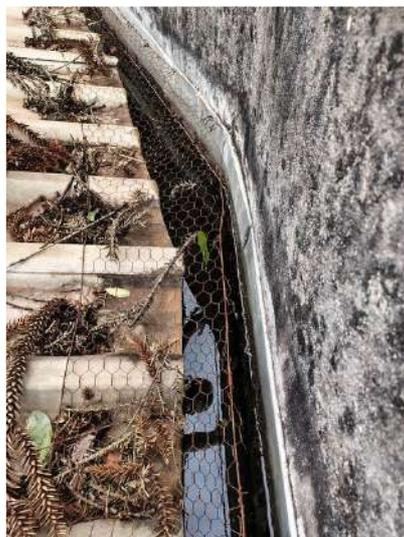
**FOTO 340 – Cobertura Auditório – Acúmulo de água em calha**
