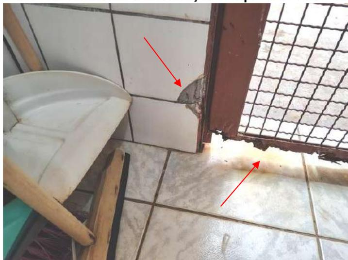
**FOTO 269 – Lavanderia – Quebra de cerâmica e deterioração completa da base da porta de fundos**
