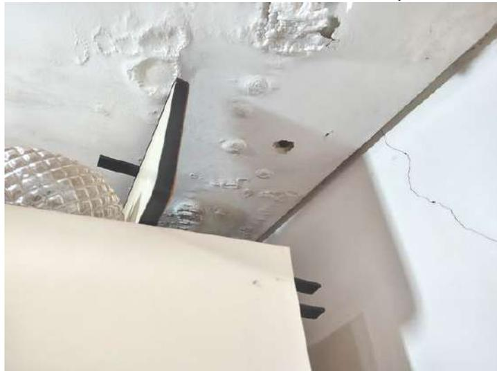
**FOTO 282 – Lavanderia – Deterioração completa do forro de gesso**
