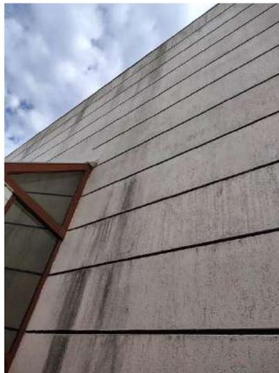
**FOTO 172 – Jardim de Inverno Fundos – Deterioração generalizada da pintura da fachada**
