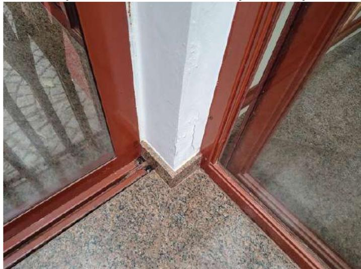
**FOTO 95 – Recepção – Umidade ao lado esquerdo da porta de entrada**
