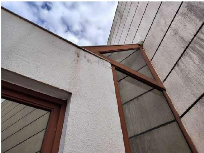
**FOTO 166 – Jardim de Inverno Fundos – Deterioração generalizada da pintura**
