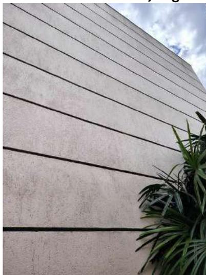
**FOTO 174 – Jardim de Inverno Fundos – Deterioração generalizada da pintura da fachada**
