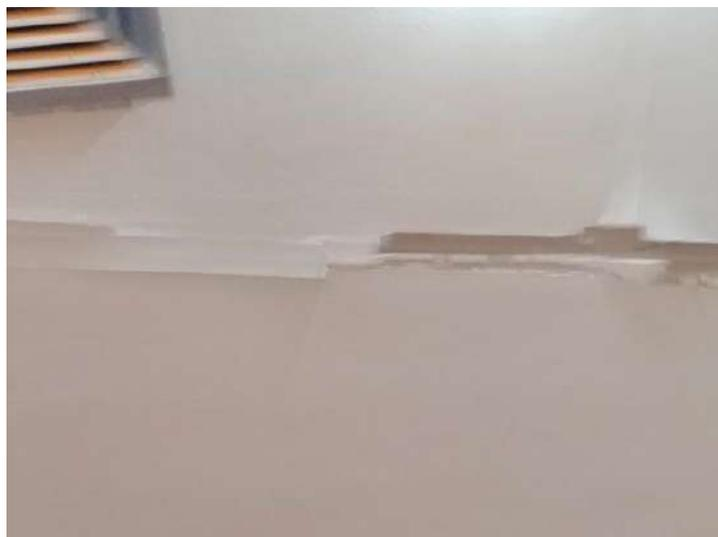
**FOTO 202 – Auditório – Deterioração generalizada do forro**
