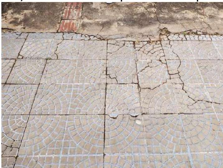
**FOTO 05 – Calçada Externa – Trincas e quebras de diversas placas cimentícias**
