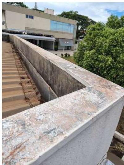
**FOTO 292 – Cobertura – Rufos com a pintura deteriorada**
