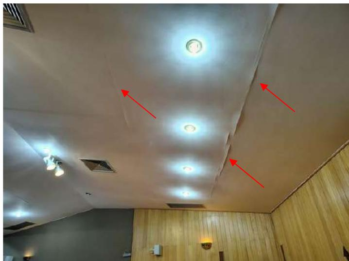
**FOTO 193 – Auditório – Deterioração generalizada do forro**
