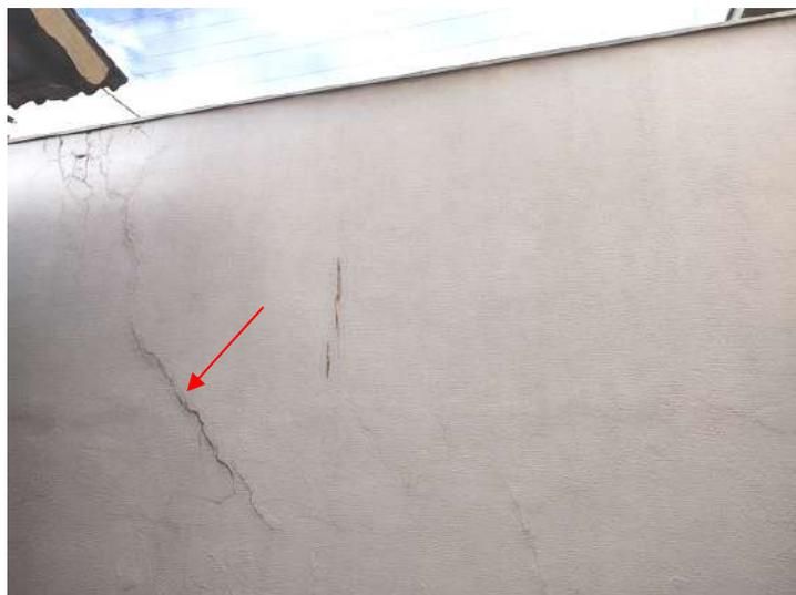
**FOTO 250 – Muro Esquerdo – Deterioração generalizada da pintura e fissuras**
