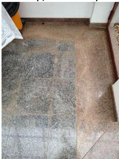
**FOTO 119 – Hall Principal – Deterioração do revestimento de pedras naturais**
