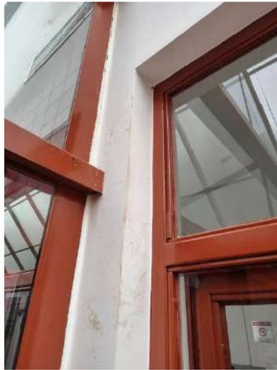
**FOTO 94 – Recepção – Umidade ao lado esquerdo da porta de entrada**
