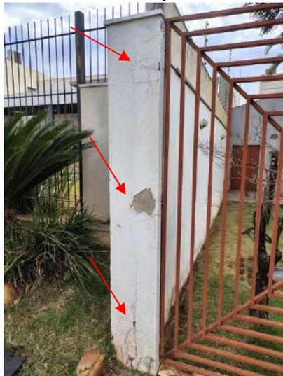
**FOTO 11 – Divisa Esquerda Frontal – Fissuras entre os muros**
