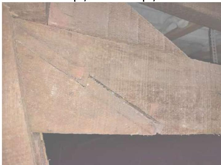
**FOTO 357 – Cobertura – Espaçamento entre peças da estrutura de madeira**
