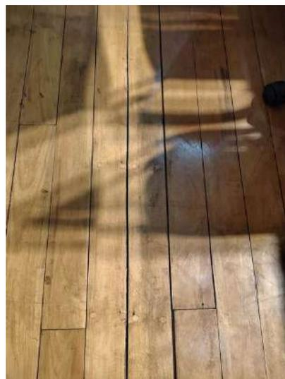
**FOTO 189 – Auditório – Tablado com desnivelamentos e aberturas entre madeiras**
