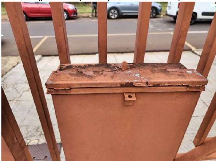
**FOTO 23 – Portão de Entrada – Oxidação e deterioração da pintura**
