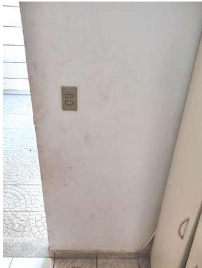
**FOTO 261 – Lavanderia – Deterioração da pintura interna**
