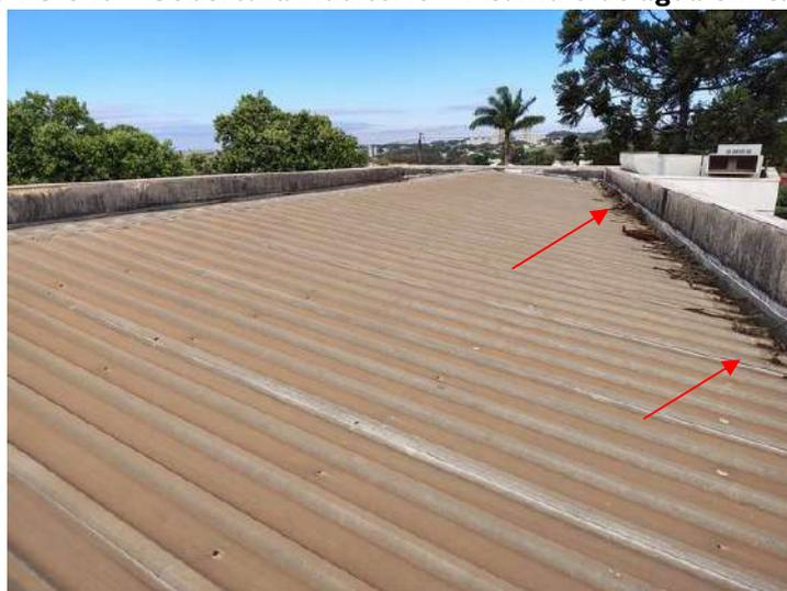
**FOTO 341 – Cobertura Auditório – Sujidades sobre as telhas e acúmulo de vegetação junto às calhas**
