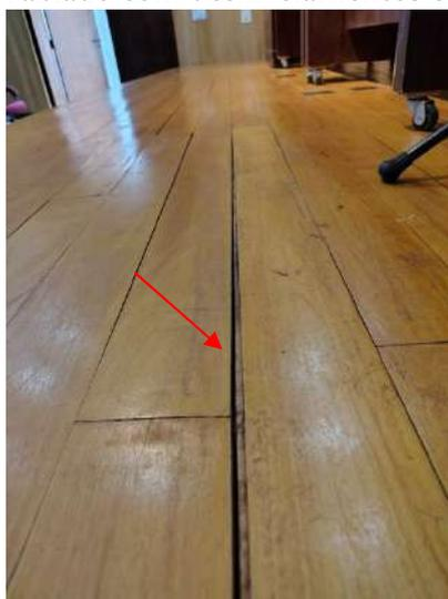
**FOTO 185 – Auditório – Tablado com desnivelamentos e aberturas entre madeiras**
