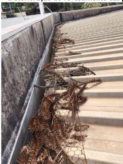
**FOTO 323 – Cobertura Auditório – Deterioração do revestimento das platibandas e acúmulo de sujidades**
