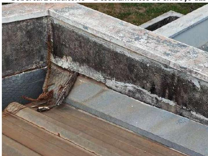
**FOTO 318 – Cobertura Auditório – Descolamentos de emboço das platibandas**
