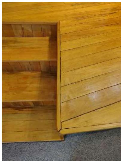
**FOTO 181 – Auditório – Tablado com desnivelamentos e aberturas entre madeiras**
