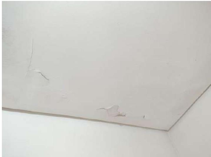
**FOTO 268 – Lavanderia – Deterioração completa do forro de gesso**
