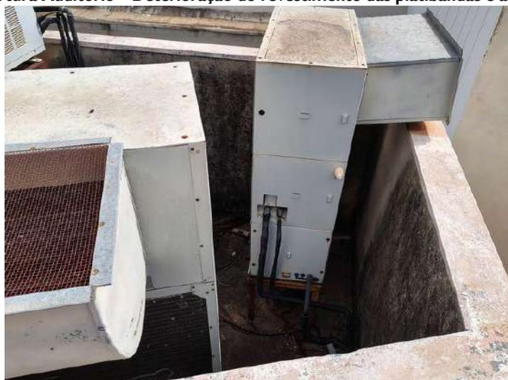
**FOTO 324 – Cobertura Auditório – Falta de manutenção da área das unidades condensadoras**
