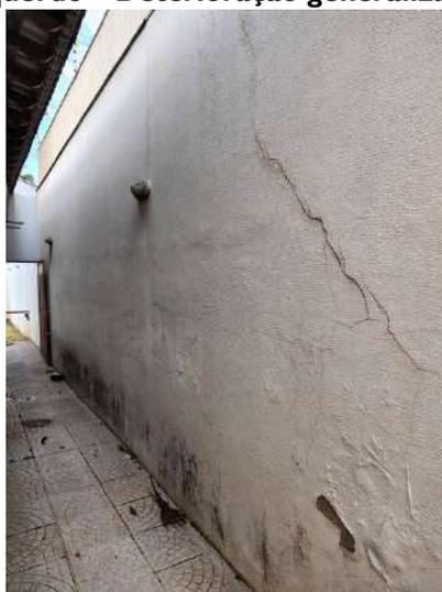
**FOTO 251 – Muro Esquerdo – Deterioração generalizada da pintura e fissuras**
