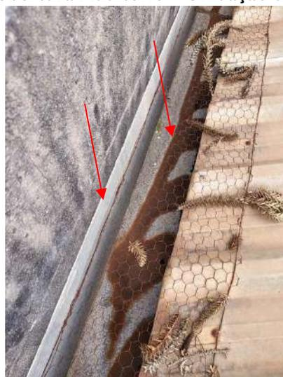
**FOTO 353 – Cobertura Auditório – Oxidação de calha metálica**
