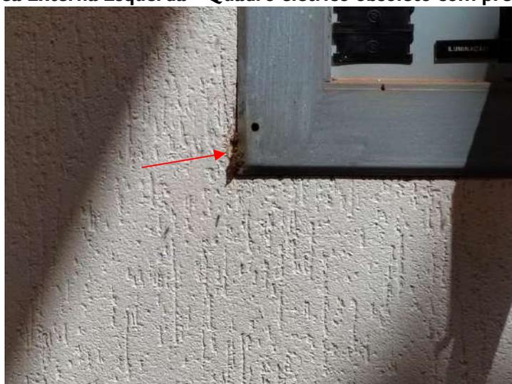
**FOTO 375 – Área Externa Esquerda – Quadro elétrico obsoleto com presença de abelhas**
