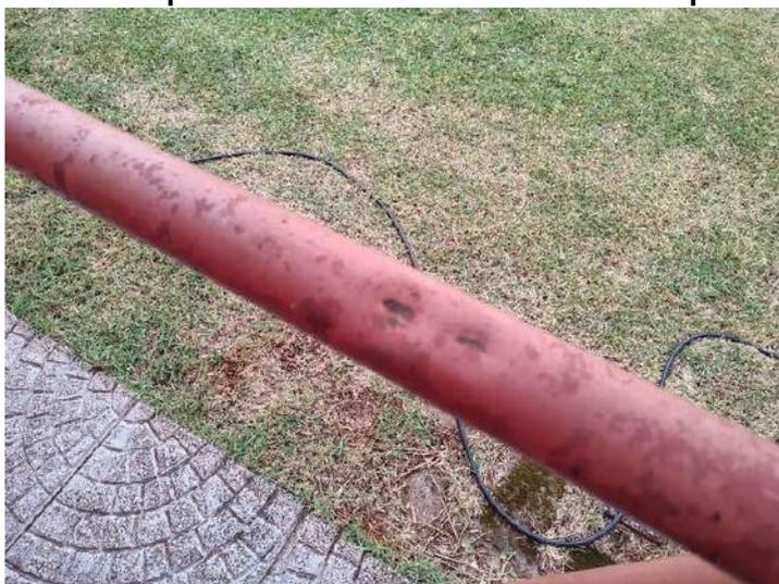
**FOTO 69 – Guarda-Corpo Frontal – Pontos do metal amassado e com oxidação**
