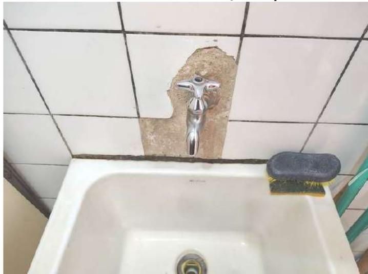
**FOTO 281 – Lavanderia – Quebras de cerâmicas junto ao tanque**
