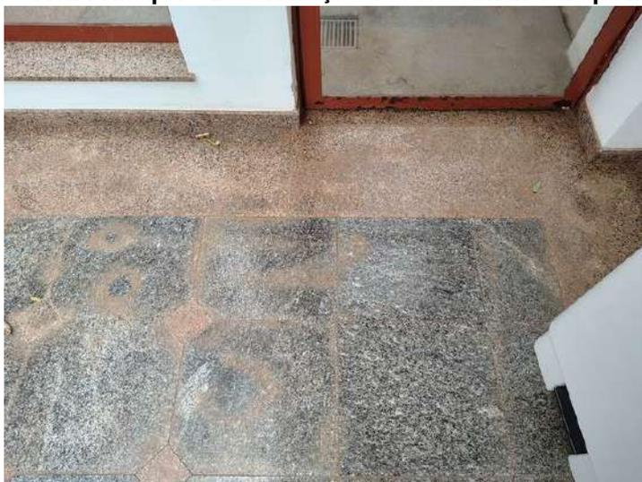
**FOTO 122 – Hall Principal – Deterioração do revestimento de pedras naturais**
