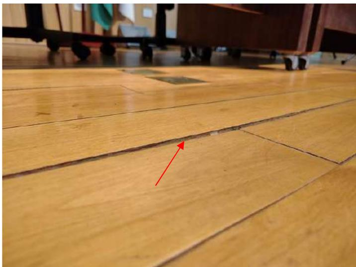
**FOTO 183 – Auditório – Tablado com desnivelamentos e aberturas entre madeiras**
