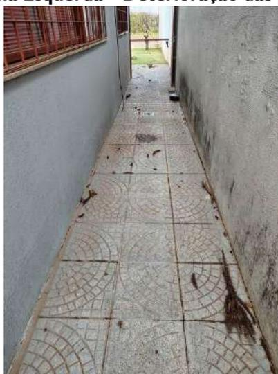
**FOTO 257 – Área Externa Esquerda – Deterioração das placas cimentícias do piso**
