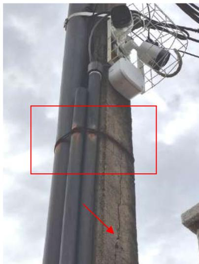
**FOTO 22 – Poste de Entrada de Energia – Deterioração da fixação dos eletrodutos/fissuração indicativa de corrosão no concreto**
