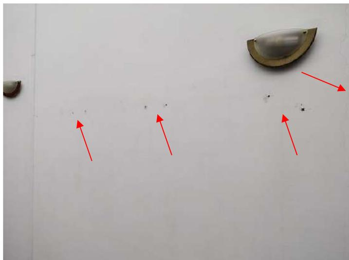
**FOTO 133 – Hall Principal – Fissuras e danos na pintura da parede**
