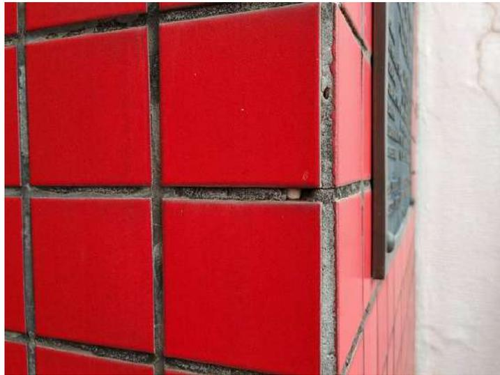
**FOTO 46 – Fachada Frontal – Perda de rejuntamento entre pastilhas cerâmicas**
