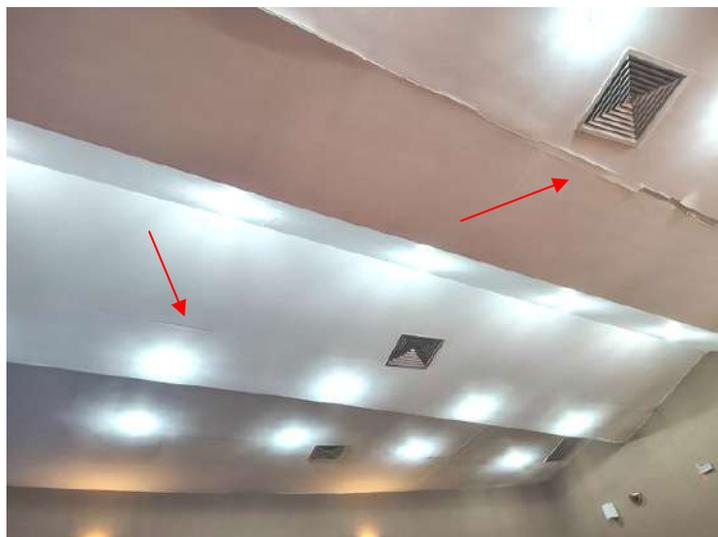
**FOTO 199 – Auditório – Deterioração generalizada do forro**
