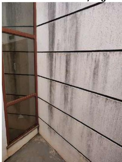
**FOTO 171 – Jardim de Inverno Fundos – Deterioração generalizada da pintura da fachada**
