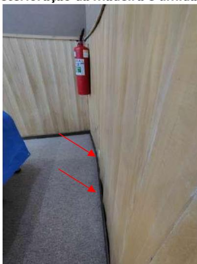
**FOTO 224 – Auditório – Deterioração da madeira e umidade nos fechamentos laterais**
