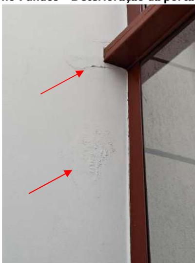
**FOTO 129 – Jardim de Inverno Fundos – Fissura e umidade ao lado esquerdo da porta**
