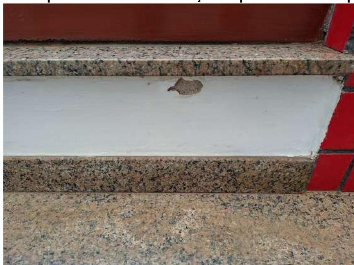
**FOTO 141 – Jardim de Inverno Central – Umidade sob esquadria com deterioração da pintura**
