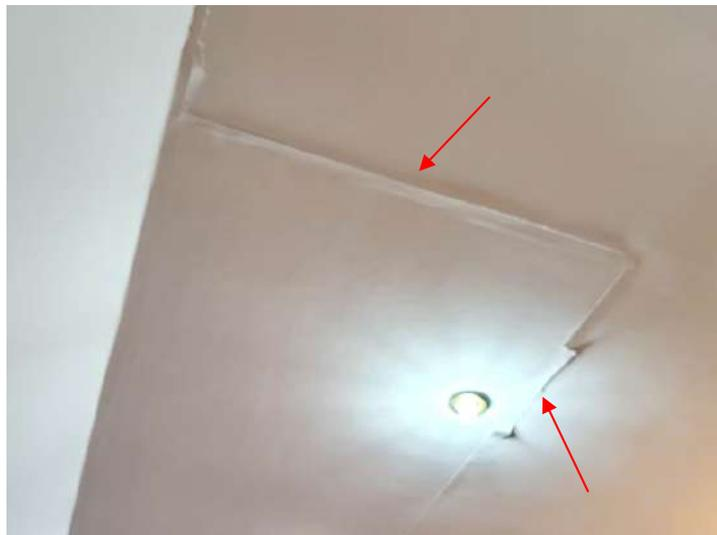
**FOTO 207 – Auditório – Deterioração generalizada do forro**
