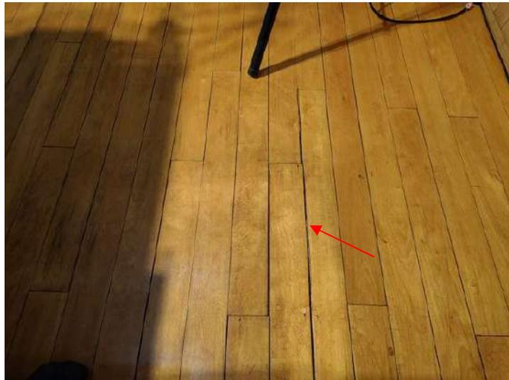
**FOTO 190 – Auditório – Tablado com desnivelamentos e aberturas entre madeiras**
