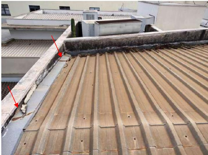
**FOTO 313 – Cobertura Auditório – Oxidação de rufo metálico e sujidades sobre telhas**
