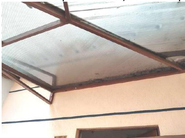
**FOTO 239 – Área Externa Esquerda – Deterioração das telhas de policarbonato**
