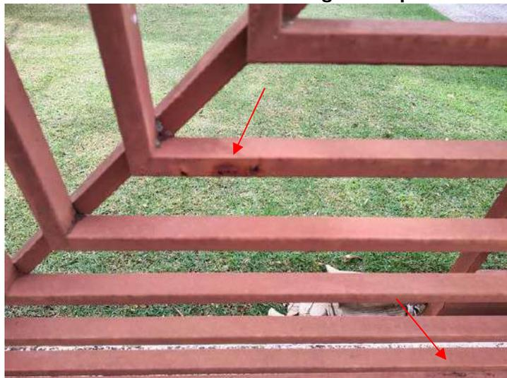
**FOTO 15 – Gradil Frontal – Pontos de oxidação/deterioração da pintura**
