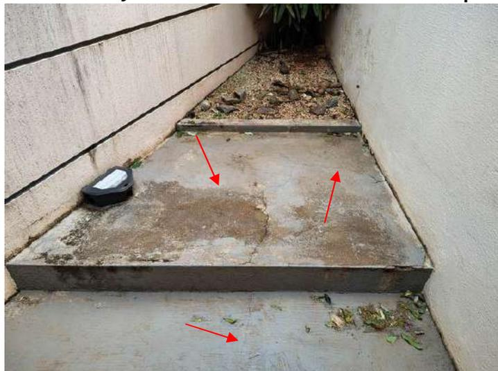
**FOTO 162 – Jardim de Inverno Fundos – Trincas no piso e deterioração da pintura**
