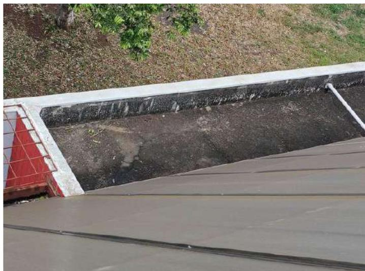
**FOTO 295 – Deterioração da impermeabilização da laje sobre banheiros**
