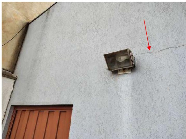
**FOTO 58 – Fachada Frontal – Deterioração generalizada da pintura e fissuras**
