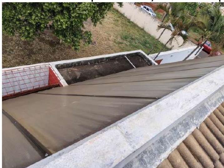
**FOTO 294 – Cobertura Hall Principal – Deterioração das telhas de policarbonato**
