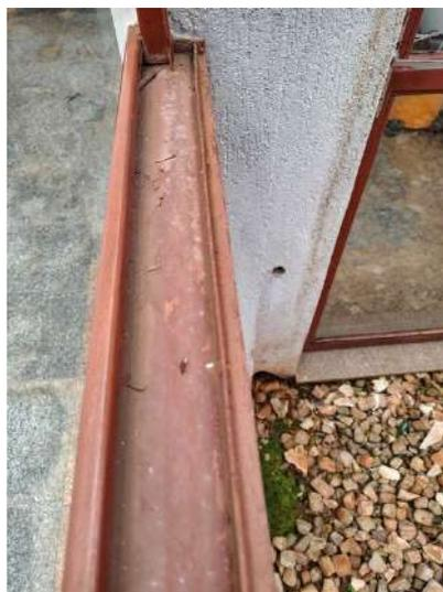
**FOTO 144 – Jardim de Inverno Central – Deterioração da pintura da esquadria**
