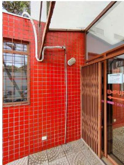
**FOTO 50 – Fachada Frontal – Deterioração do revestimento cerâmico e da estrutura de cobertura**
