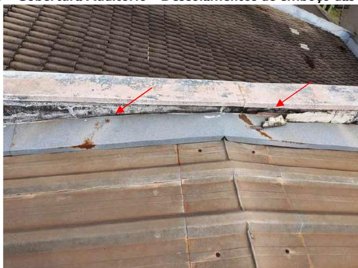
**FOTO 321 – Cobertura Auditório – Descolamentos de emboço das platibandas e rufo oxidado**
