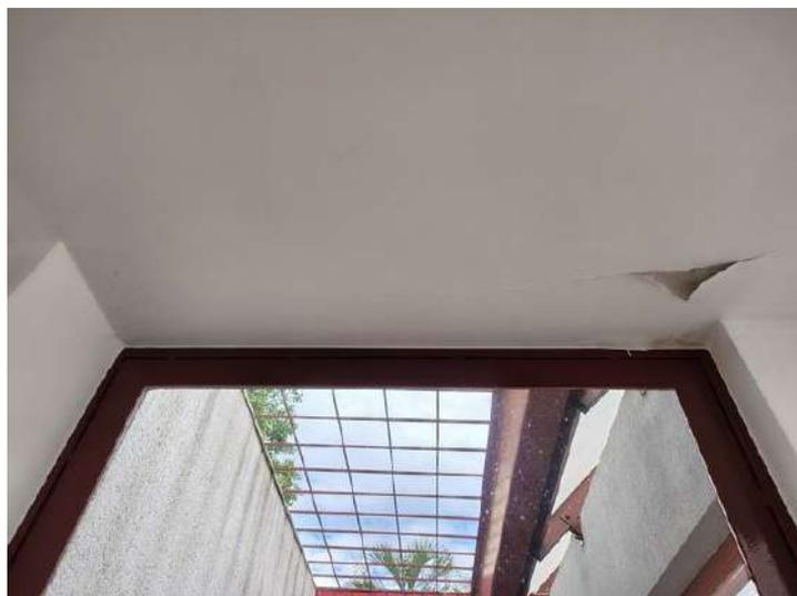
**FOTO 157 – Jardim de Inverno Central – Fissura e descolamento da pintura acima da porta**
