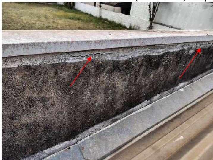
**FOTO 336 – Cobertura Auditório – Fissuração do emboço da platibanda**
