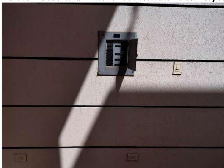
**FOTO 374 – Área Externa Esquerda – Quadro elétrico obsoleto com presença de abelhas**
