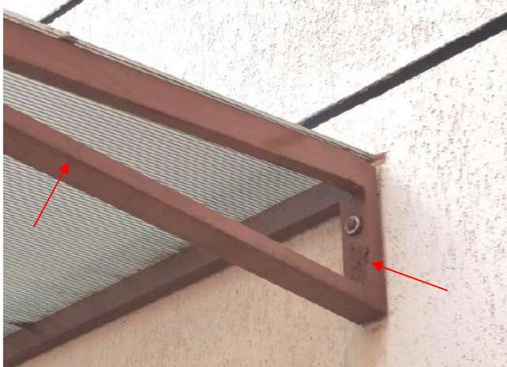
**FOTO 234 – Área Externa Esquerda – Oxidação da estrutura da cobertura**
