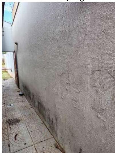
**FOTO 252 – Muro Esquerdo – Deterioração generalizada da pintura e fissuras**
