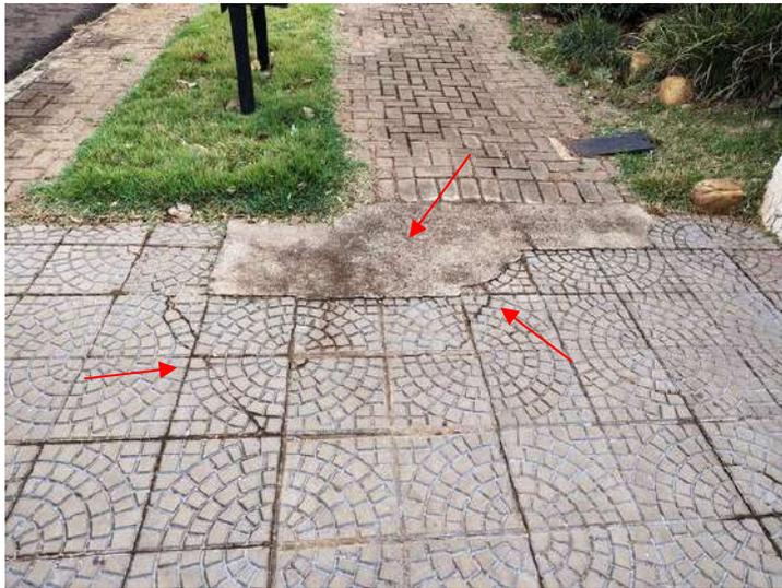
**FOTO 10 – Calçada Externa – Trincas e quebras de diversas placas cimentícias**
