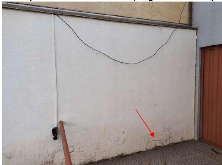
**FOTO 33 – Muro Esquerdo Frontal – Deterioração generalizada da pintura e fissuras**
