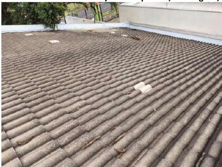
**FOTO 305 – Cobertura – Telhas com sujidades e presença de vegetação em excesso**
