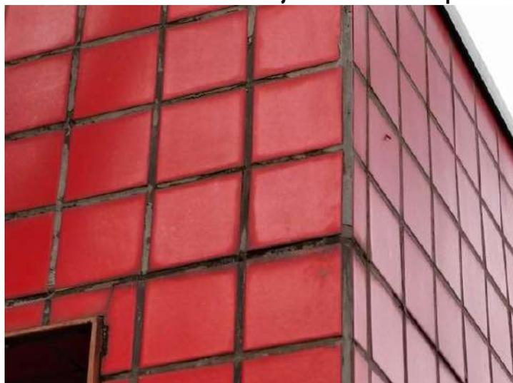
**FOTO 54 – Fachada Frontal – Perda do rejuntamento entre pastilhas cerâmicas**
