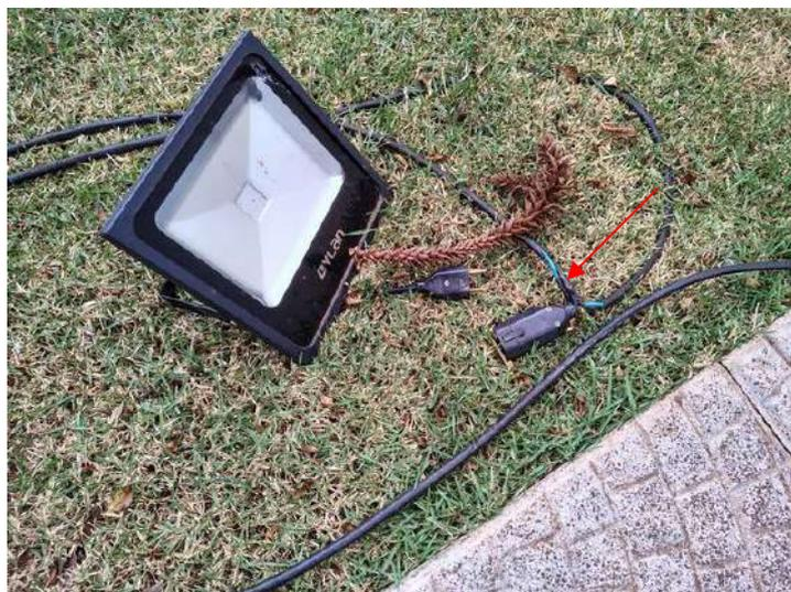
**FOTO 178 – Área Frontal – Iluminação instalada com fiação exposta**
