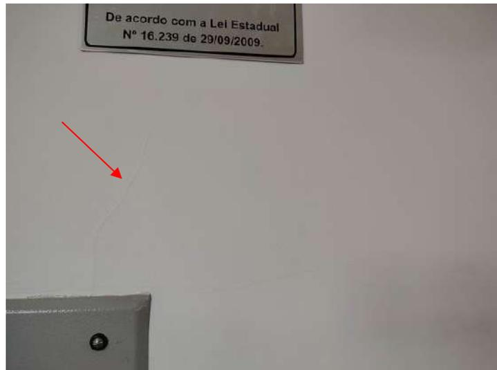
**FOTO 112 – Recepção – Fissura sobre o quadro de energia**
