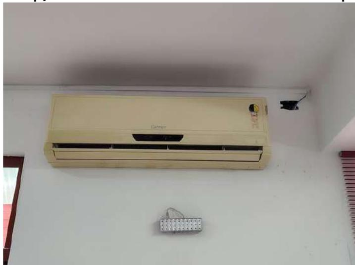
**FOTO 117 – Recepção – Aparelho antigo de ar condicionado, sem revisão recente**
