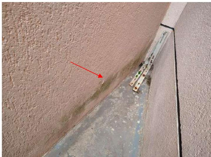
**FOTO 277 – Lavanderia – Área externa – Infiltração de umidade no muro esquerdo**
