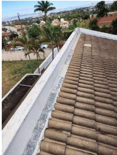
**FOTO 307 – Cobertura – Deterioração da pintura dos rufos metálicos**
