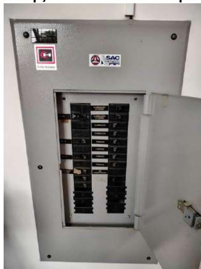
**FOTO 113 – Recepção – Quadro QDG c/ disjuntores antigos, sem proteções de DPS e DR**
