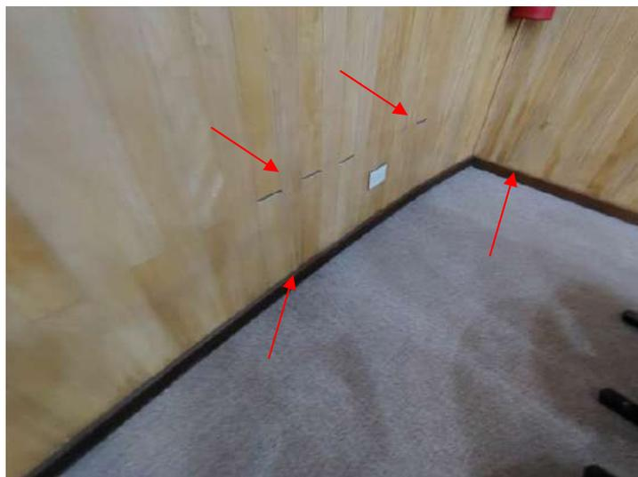
**FOTO 226 – Auditorio – Deterioração da madeira e umidade nos fechamentos laterais**
