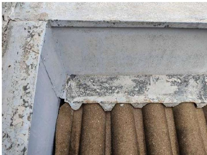
**FOTO 289 – Cobertura – Rufos com a pintura deteriorada**
