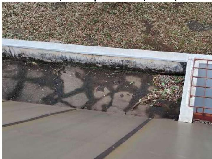
**FOTO 297 – Deterioração da impermeabilização da laje sobre hall principal**
