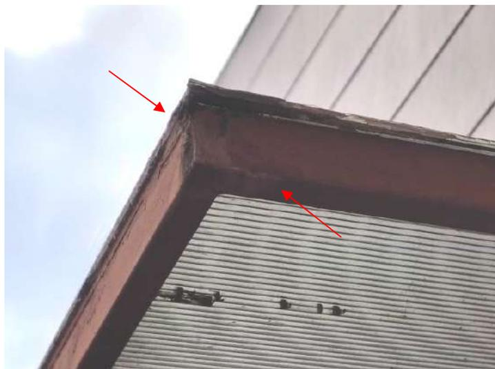
**FOTO 235 – Área Externa Esquerda – Oxidação da estrutura da cobertura**
