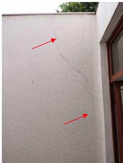
**FOTO 169 – Jardim de Inverno Fundos – Fissuras e deterioração generalizada da pintura**
