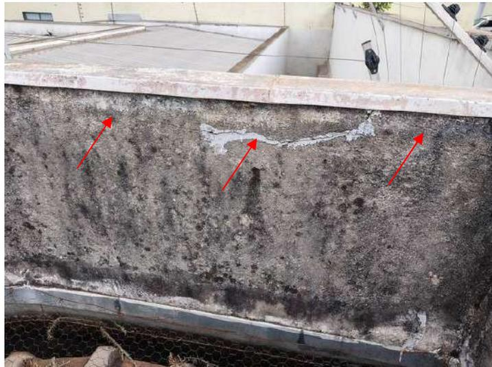
**FOTO 343 – Cobertura Auditório – Fissuração do emboço da platibanda**
