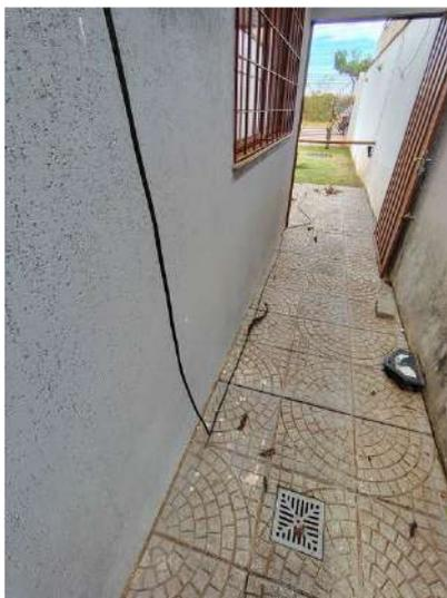
**FOTO 232 – Área Externa Esquerda – Cabo da iluminação frontal exposto**
