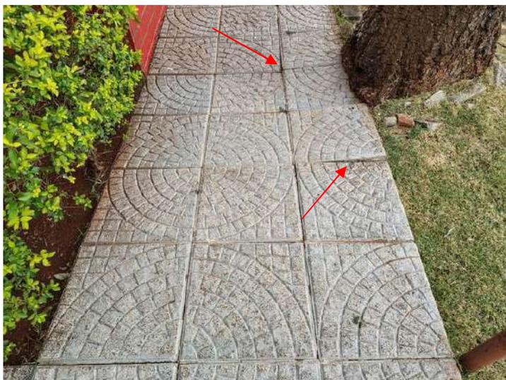
**FOTO 64 – Calçada Frontal Esquerda – Deslocamento de placas juto à árvore**
