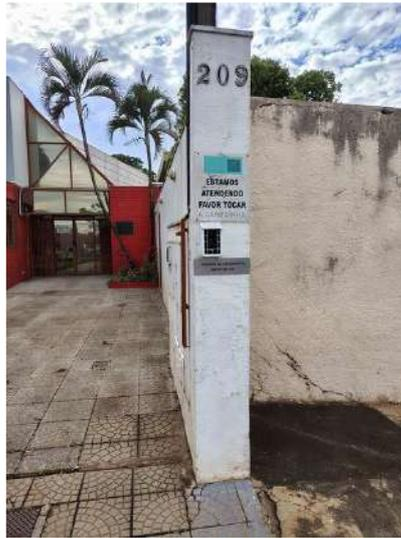
**FOTO 19 – Divisa Direita Frontal – Deterioração da pintura**
