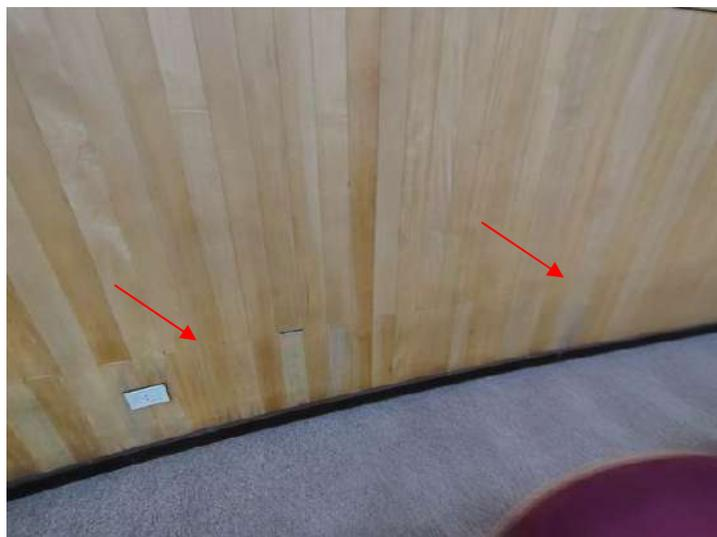
**FOTO 220 – Auditorio – Deterioração da madeira e umidade nos fechamentos laterais**
