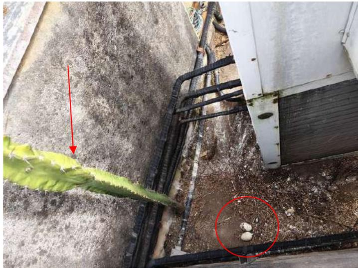
**FOTO 325 – Cobertura Auditório – Falta de manutenção da área das unidades condensadoras**
