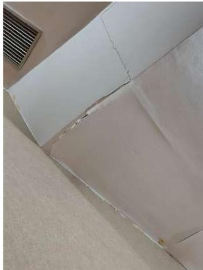
**FOTO 205 – Auditório – Deterioração generalizada do forro**
