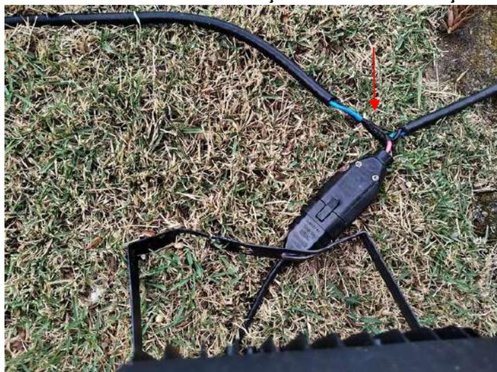
**FOTO 177 – Área Frontal – Iluminação instalada com fiação exposta**
