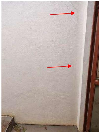
**FOTO 168 – Jardim de Inverno Fundos – Fissuras e deterioração generalizada da pintura**
