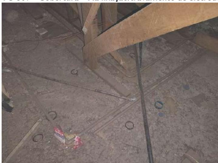
**FOTO 368 – Cobertura – Falta de limpeza e tubulações expostas na laje sem proteção**
