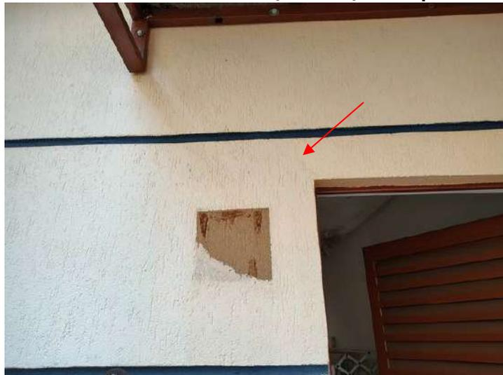
**FOTO 245 – Lavanderia – Fissura no canto da porta de entrada e falta de pintura**
