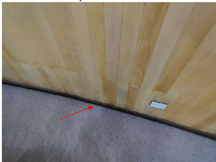
**FOTO 222 – Auditorio – Deterioração da madeira e umidade nos fechamentos laterais**
