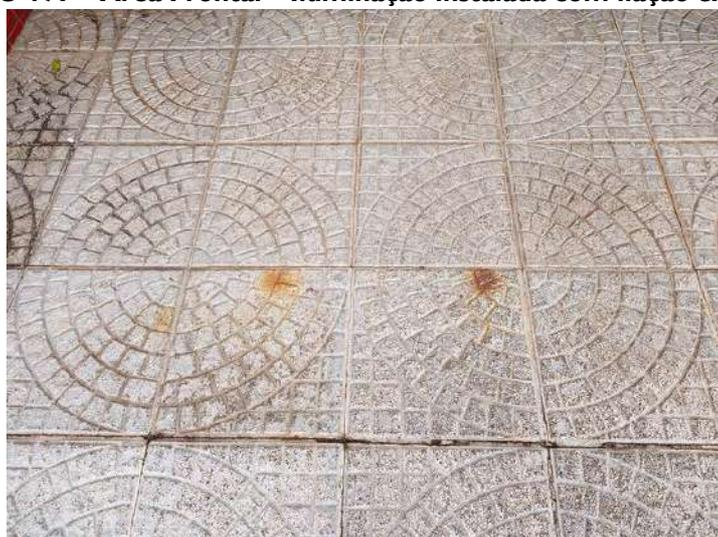
**FOTO 180 – Hall de Entrada Externo – Placas cimentícias deterioradas e com manchas de oxidação advindas da cobertura**
