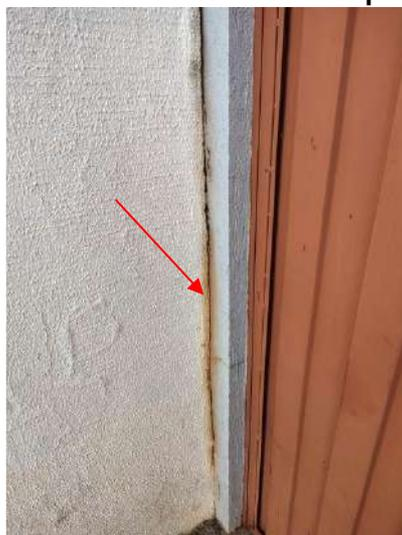
**FOTO 60 – Fachada Frontal – Porta de acesso lateral esquerdo com pontos de oxidação**
