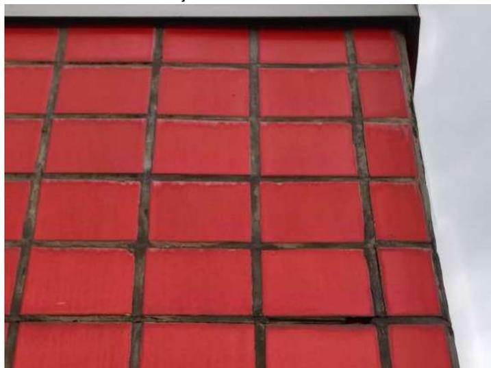
**FOTO 51 – Fachada Frontal – Perda do rejuntamento entre pastilhas cerâmicas**
