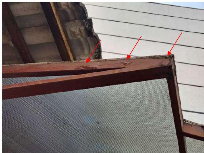
**FOTO 241 – Área Externa Esquerda – Oxidação da estrutura metálica de cobertura**
