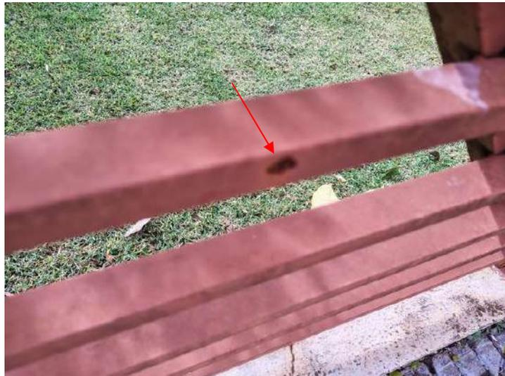
**FOTO 13 – Gradil Frontal – Pontos de oxidação/deterioração da pintura**
