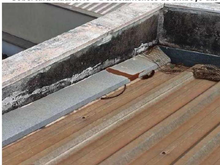
**FOTO 320 – Cobertura Auditório – Descolamentos de emboço das platibandas**
