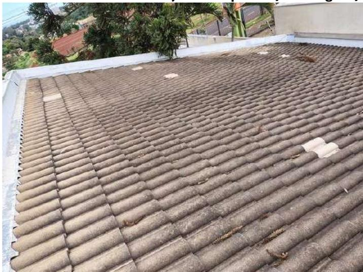
**FOTO 306 – Cobertura – Telhas com sujidades e presença de vegetação em excesso**
