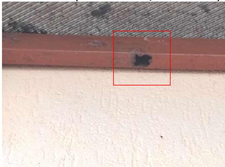
**FOTO 240 – Área Externa Esquerda – Oxidação causou buraco na estrutura metálica**
