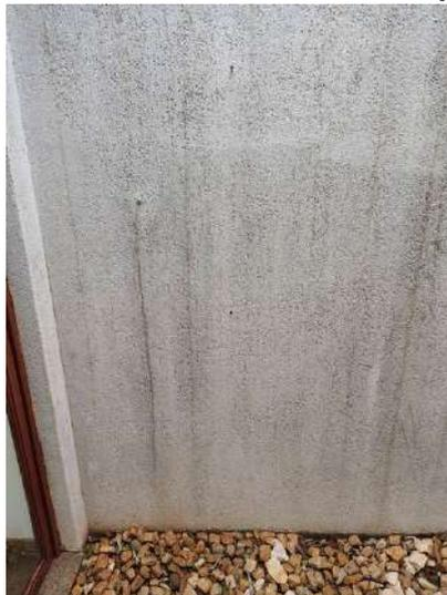
**FOTO 146 – Jardim de Inverno Central – Deterioração da pintura das paredes internas**
