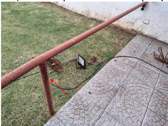
**FOTO 66 – Guarda-Corpo Frontal – Deterioração da pintura e pontos de oxidação**
