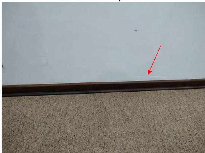
**FOTO 104 – Sala de Reunião – Fissura presente na parede oposta à recepção**
