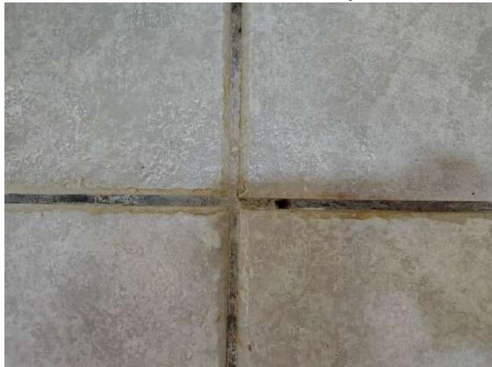
**FOTO 80 - WC Masculino - Deterioração do rejuntamento do piso**
