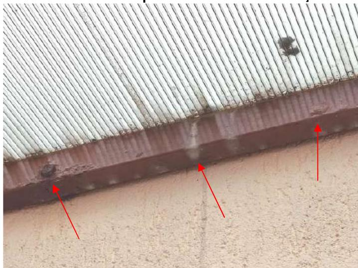
**FOTO 237 – Área Externa Esquerda – Pontos de infiltração e oxidação na cobertura**
