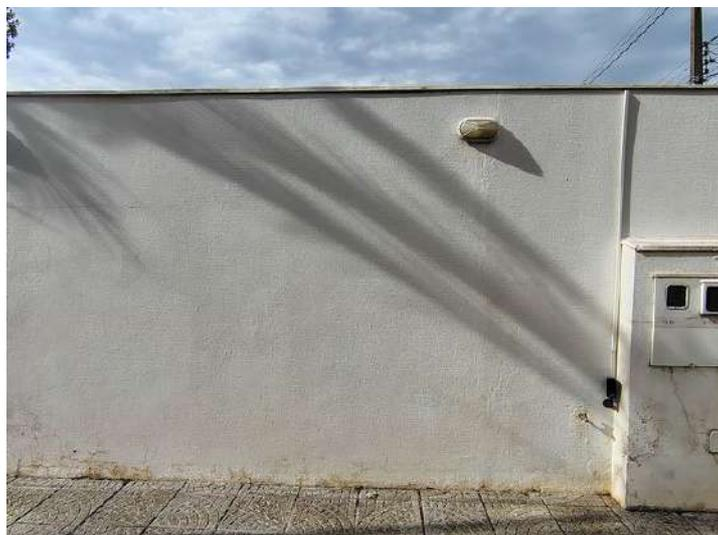
**FOTO 37 – Muro Direito Frontal - Deterioração generalizada da pintura e fissuras**
