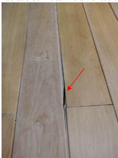
**FOTO 186 – Auditório – Tablado com desnivelamentos e aberturas entre madeiras**
