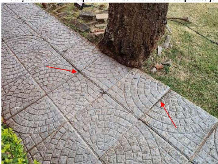
**FOTO 65 – Calçada Frontal Esquerda – Deslocamento de placas juto à árvore**
