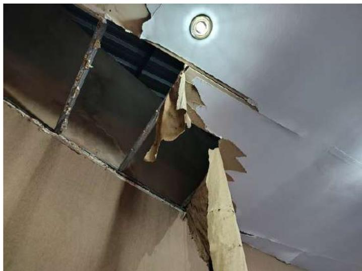
**FOTO 213 – Auditório – Fundos – Forro danificado em virtude de infiltrações**
