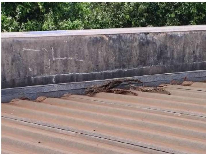
**FOTO 346 – Cobertura Auditório – Deterioração e fissuração do emboço da platibanda**
