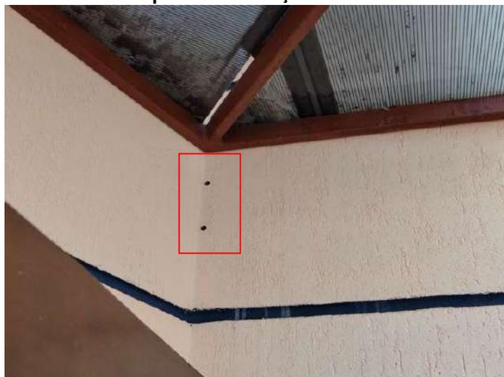
**FOTO 243 – Área Externa Esquerda – Furos na alvenaria sob a cobertura**
