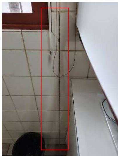
**FOTO 106 – Copa – Trinca em cerâmica e entre rejuntas, lado direito da janela**
