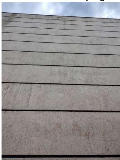
**FOTO 173 – Jardim de Inverno Fundos – Deterioração generalizada da pintura da fachada**
