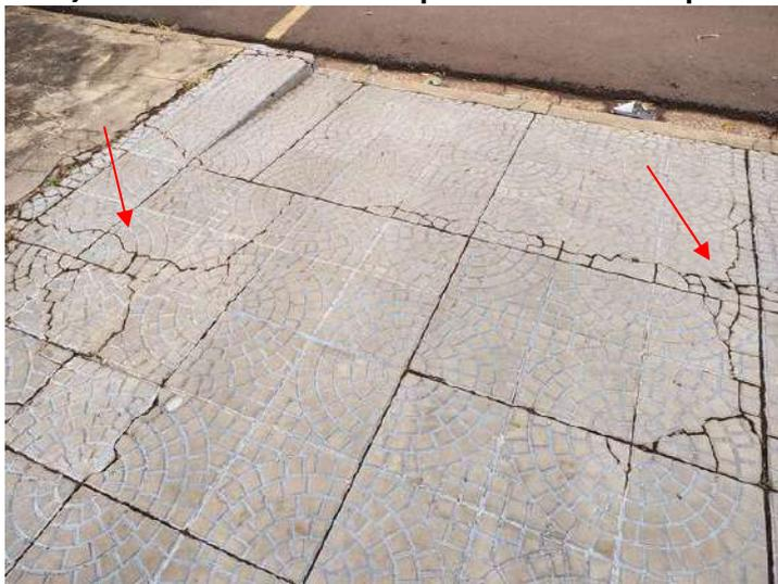
**FOTO 06 – Calçada Externa – Trincas e quebras de diversas placas cimentícias**
