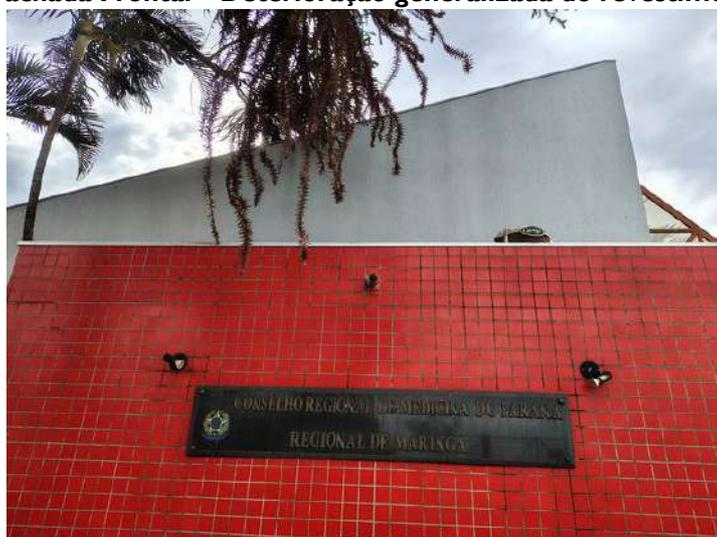
**FOTO 72 – Fachada Frontal – Deterioração generalizada do revestimento cerâmico**
