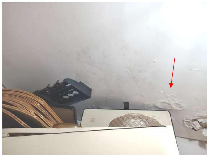
**FOTO 265 – Lavanderia – Deterioração completa do forro de gesso**
