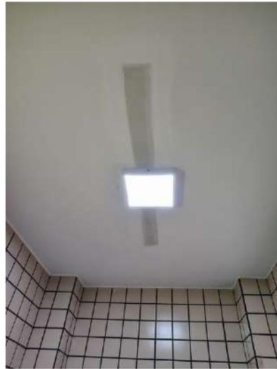
**FOTO 79 - WC Masculino - Falha na pintura do teto**
