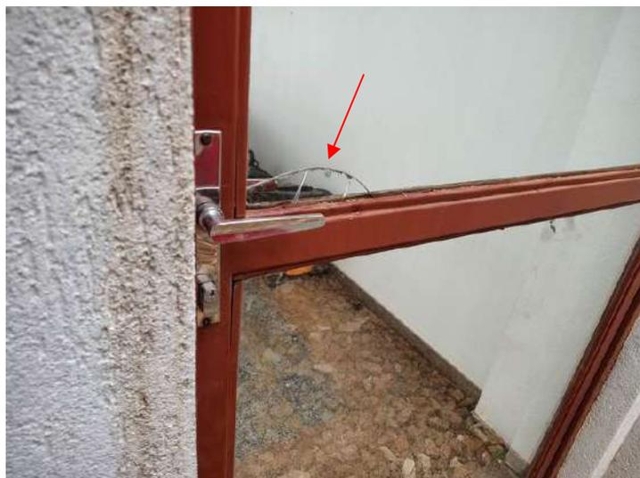
**FOTO 151 – Jardim de Inverno Central – Vidro da porta trincado**
