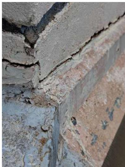
**FOTO 302 – Cobertura – Descolamento do rufo metálico e ausência de vedação**
