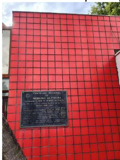
**FOTO 45 – Fachada Frontal – Perda de rejuntamento entre pastilhas cerâmicas**
