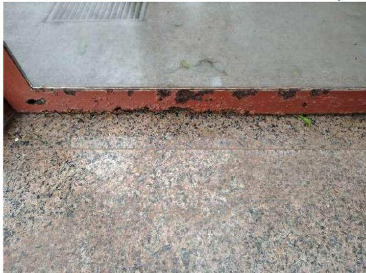
**FOTO 125 – Jardim de Inverno Fundos – Deterioração da base da porta por oxidação**
