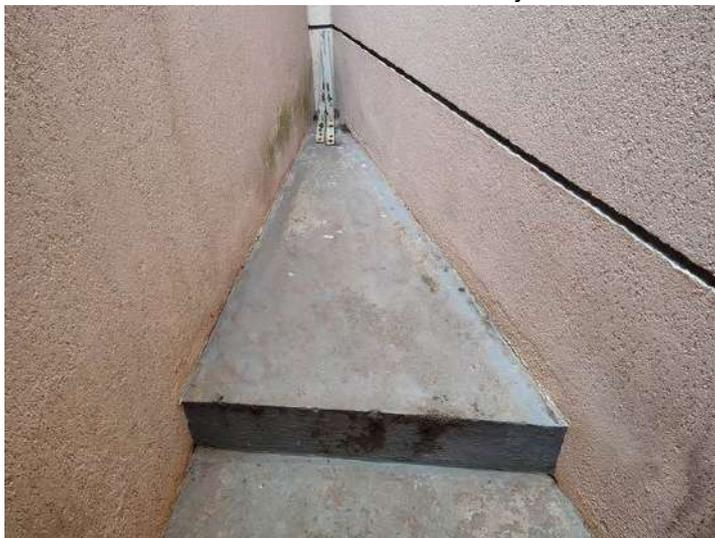
**FOTO 273 – Lavanderia – Área externa – Deterioração do revestimento do piso**
