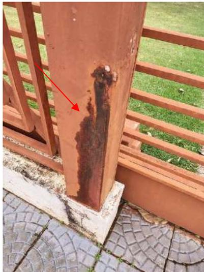
**FOTO 20 – Gradil Frontal – Pontos de oxidação/deterioração da pintura**
