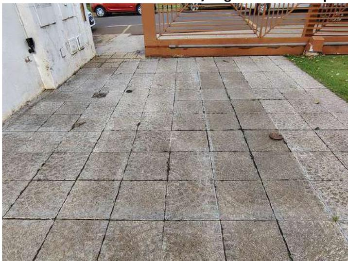
**FOTO 41 – Entrada de Veículos – Desgaste superficial das placas cimentícias e falhas no rejuntamento**
