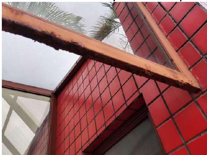
**FOTO 47 – Fachada Frontal – Perda de rejuntamento entre pastilhas cerâmicas**
