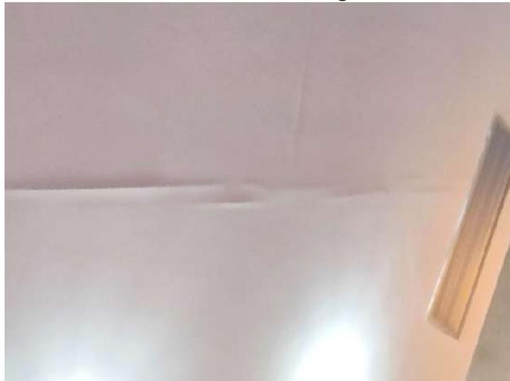
**FOTO 204 – Auditório – Deterioração generalizada do forro**
