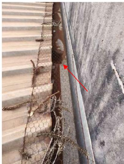
**FOTO 352 – Cobertura Auditório – Oxidação de calha metálica**
