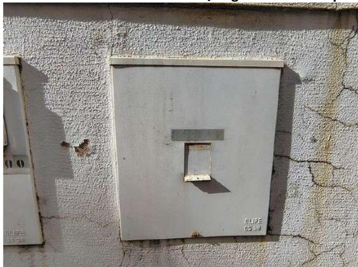
**FOTO 36 – Muro Direito Frontal - Deterioração generalizada da pintura e fissuras**
