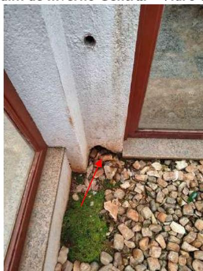
**FOTO 152 – Jardim de Inverno Central – Abertura na base da alvenaria interna**
