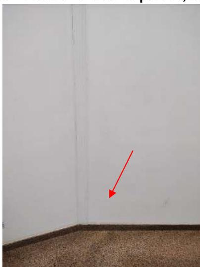
**FOTO 137 – Hall Principal – Fissura na base da parede, lado esquerdo do Auditório**
