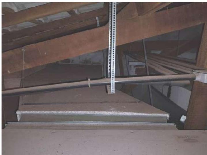
**FOTO 364 – Cobertura – Má fixação/travamento de eletrodutos**
