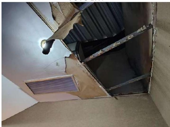
**FOTO 212 – Auditório – Fundos – Forro danificado em virtude de infiltrações**
