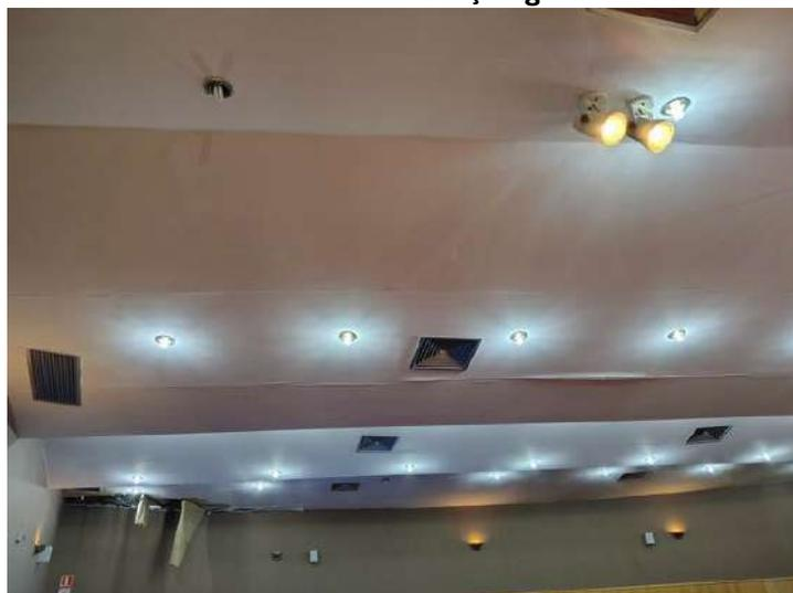
**FOTO 195 – Auditório – Deterioração generalizada do forro**
