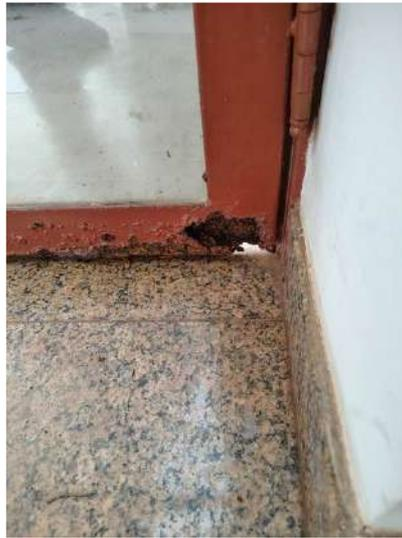
**FOTO 124 – Jardim de Inverno Fundos – Deterioração da base da porta por oxidação**
