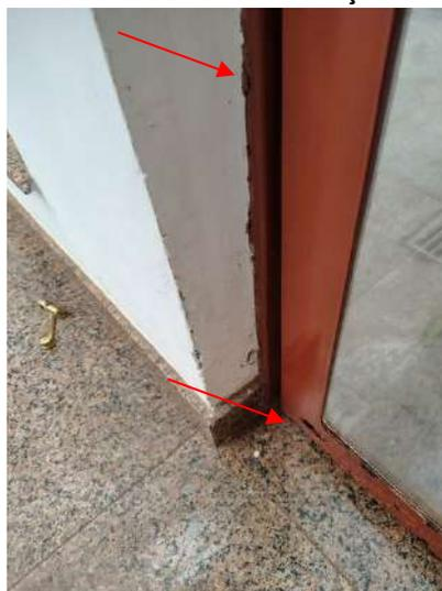
**FOTO 126 – Jardim de Inverno Fundos – Deterioração da porta por oxidação**
