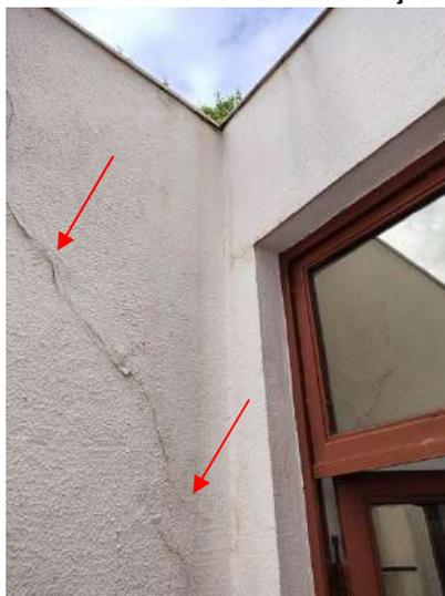
**FOTO 167 – Jardim de Inverno Fundos – Fissuras e deterioração generalizada da pintura**
