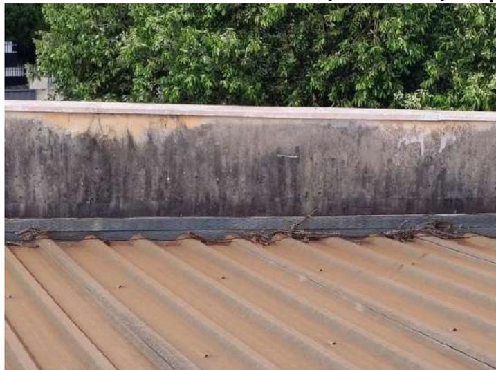
**FOTO 345 – Cobertura Auditório – Deterioração do emboço da platibanda**
