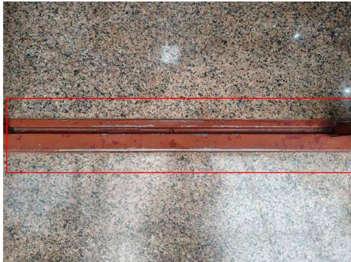
**FOTO 97 – Recepção – Deterioração do revestimento na base da porta de entrada**
