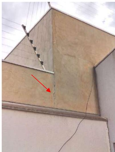
**FOTO 34 – Muro Esquerdo Frontal – Deterioração generalizada da pintura e fissuras**
