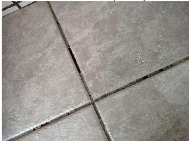
**FOTO 81 - WC Masculino - Deterioração do rejuntamento do piso**
