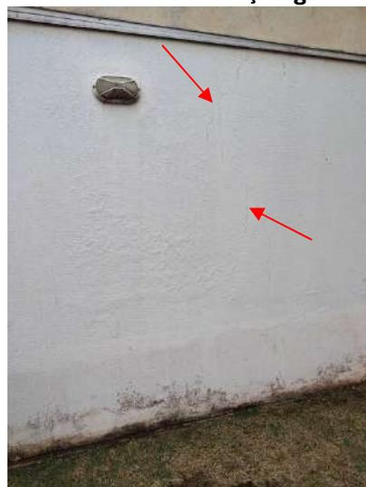
**FOTO 30 – Muro Esquerdo Frontal – Deterioração generalizada da pintura e fissuras**
