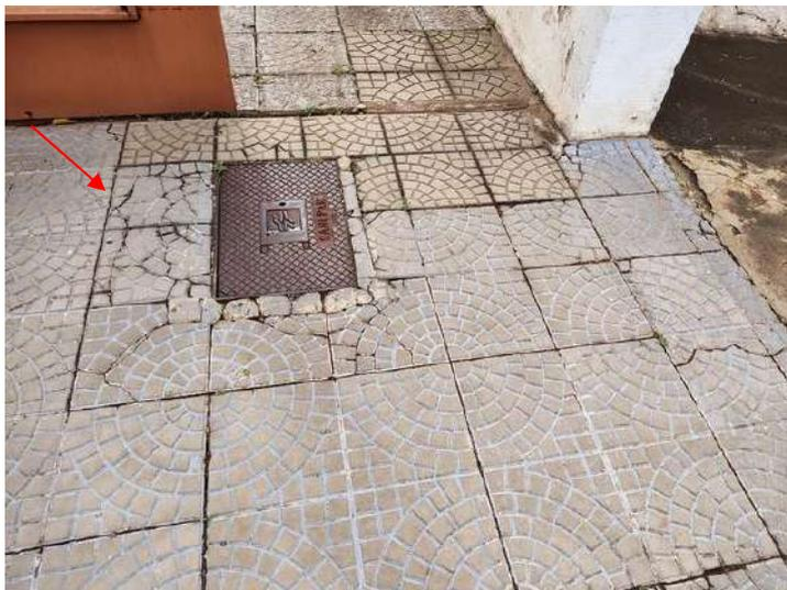
**FOTO 04 – Calçada Externa – Trincas e quebras de diversas placas cimentícias**
