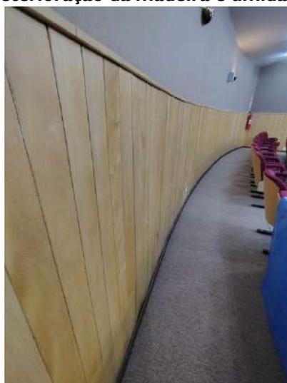
**FOTO 225 – Auditório – Deterioração da madeira e umidade nos fechamentos laterais**
