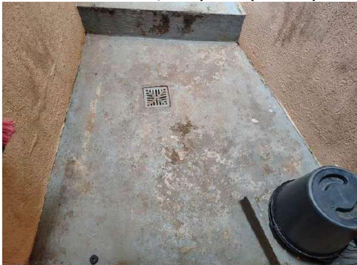
**FOTO 272 – Lavanderia – Área externa – Deterioração do revestimento do piso**
