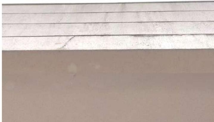
**FOTO 259 – Reservatório Superior – Deterioração da pintura das fachadas e laje inferior**
