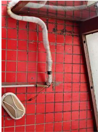
**FOTO 49 – Fachada Frontal – Deterioração do revestimento cerâmico**
