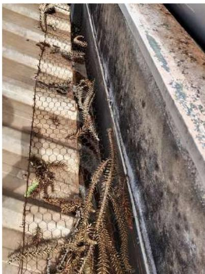
**FOTO 322 – Cobertura Auditório – Deterioração do revestimento das platibandas e acúmulo de sujidades**
