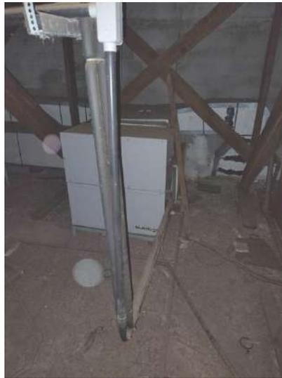
**FOTO 370 – Cobertura – Má fixação/travamento de eletrodutos**
