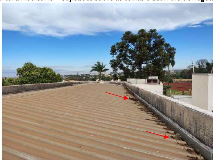
**FOTO 342 – Cobertura Auditório – Sujidades sobre as telhas e acúmulo de vegetação junto às calhas**
