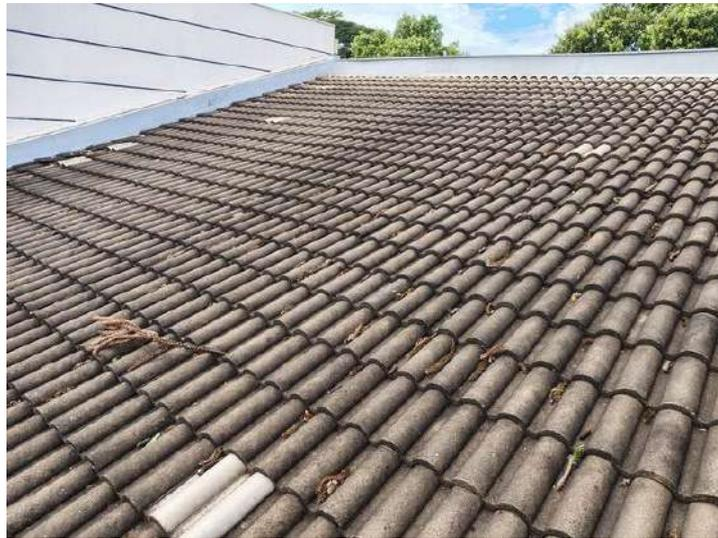
**FOTO 286 – Cobertura – Telhas com sujidades e presença de vegetação em excesso**
