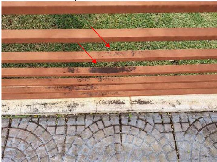
**FOTO 12 – Gradil Frontal – Pontos de oxidação/deterioração da pintura**
