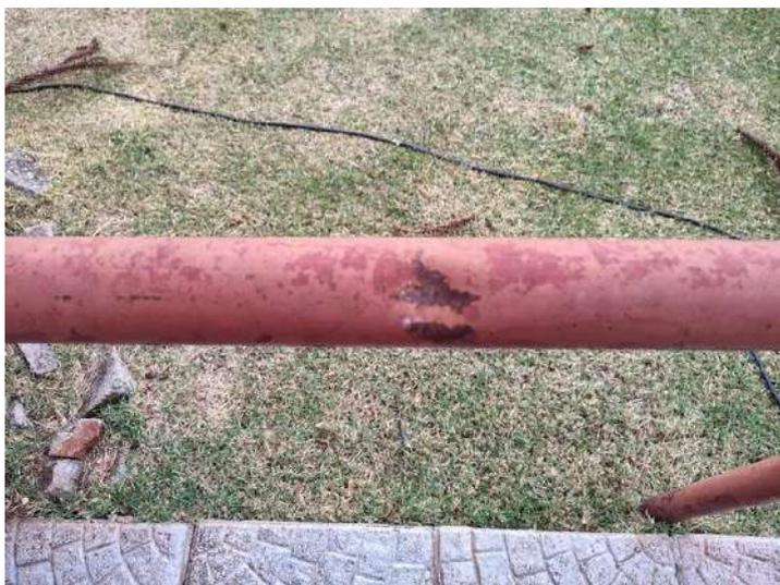
**FOTO 67 – Guarda-Corpo Frontal – Pontos do metal amassado e com oxidação**
