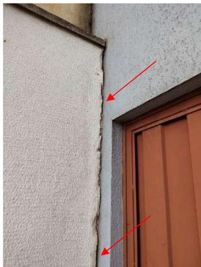
**FOTO 61 – Fachada Frontal – Fissura de descolamento junto ao muro esquerdo**
