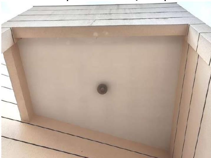
**FOTO 258 – Reservatório Superior – Deterioração da pintura das fachadas e laje inferior**
