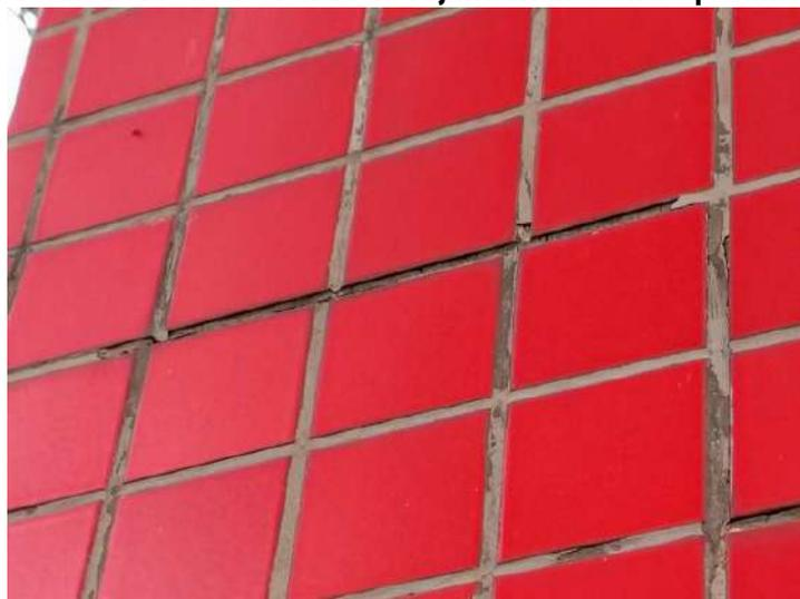
**FOTO 53 – Fachada Frontal – Perda do rejuntamento entre pastilhas cerâmicas**
