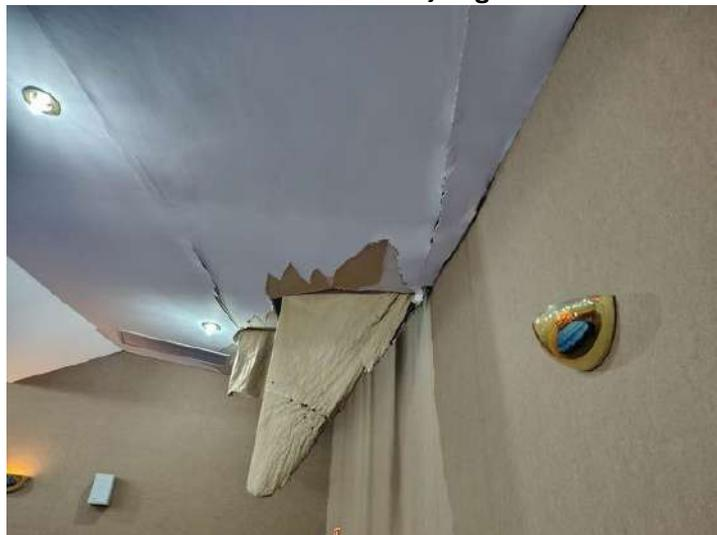
**FOTO 210 – Auditório – Fundos – Forro danificado em virtude de infiltrações**
