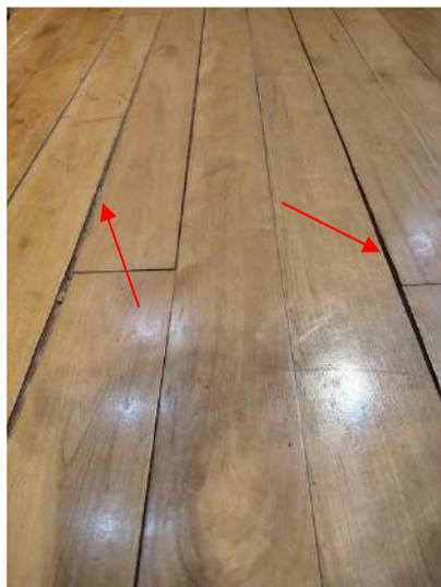
**FOTO 184 – Auditório – Tablado com desnivelamentos e aberturas entre madeiras**
