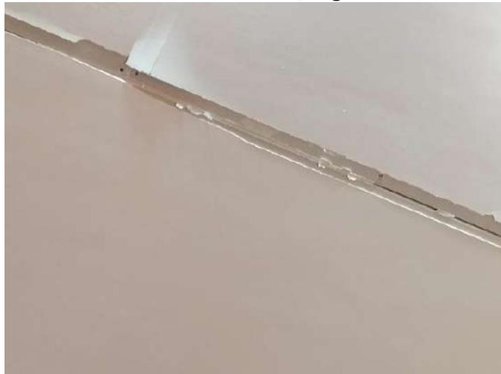
**FOTO 201 – Auditório – Deterioração generalizada do forro**
