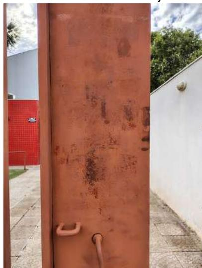
**FOTO 18 – Gradil Frontal – Pontos de oxidação/deterioração da pintura**
