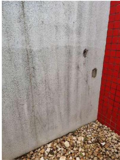
**FOTO 145 – Jardim de Inverno Central – Deterioração da pintura das paredes internas**
