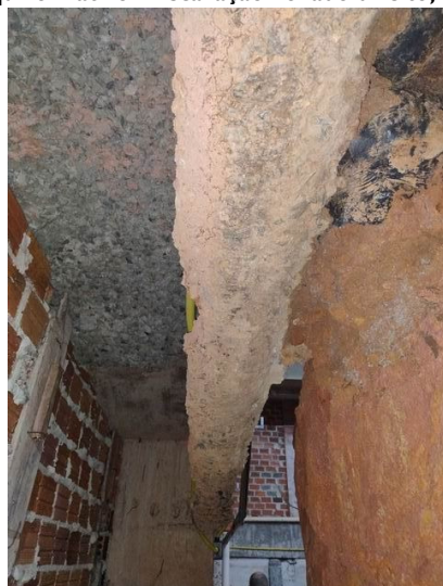
FOTO 27 – Subsolo ao lado do Arquivo Inativo – Escavação no lado direito, expondo a base do piso do auditório
