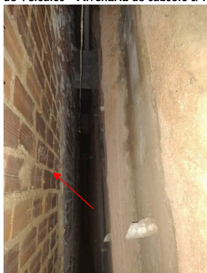
FOTO 44 – Subsolo sob a Rampa de Veículos – Alvenaria do subsolo s/ revestimento e impermeabilização
