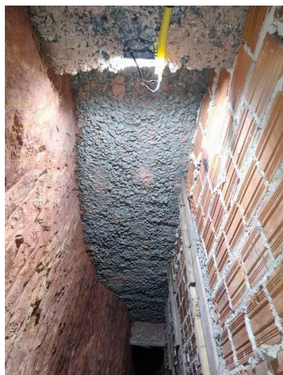
FOTO 34 – Subsolo ao lado do Arquivo Inativo – Escavação nos fundos expondo a base do piso do auditório
