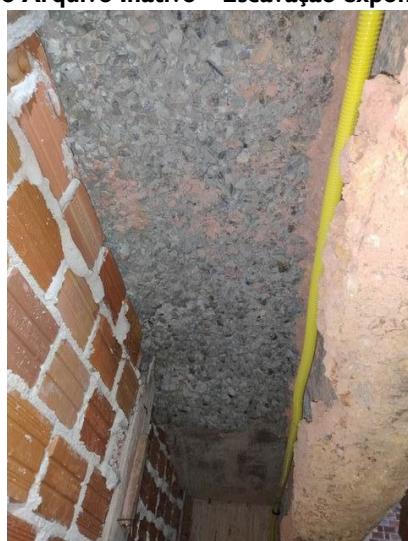
FOTO 32 – Subsolo ao lado do Arquivo Inativo – Escavação expondo a base do piso do auditório
