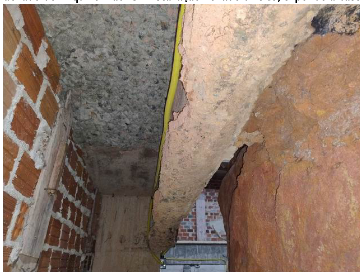
FOTO 26 – Subsolo ao lado do Arquivo Inativo – Escavação no lado direito, expondo a base do piso do auditório
