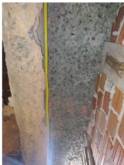
FOTO 31 – Subsolo ao lado do Arquivo Inativo – Escavação expondo a base do piso do auditório
