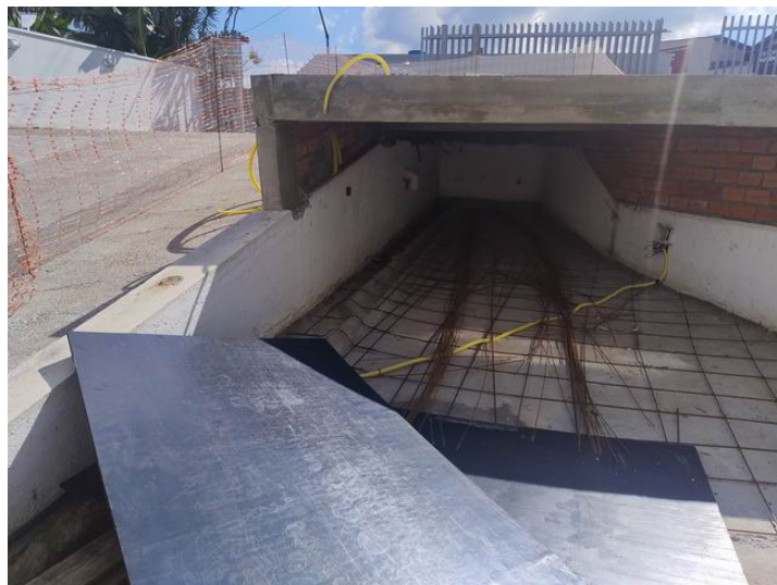
FOTO 01 – Vista geral da área em que está sendo construída a Guarita
