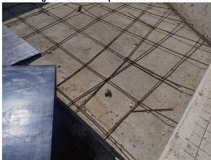
FOTO 03 – Laje de piso já existente no local da futura Guarita
