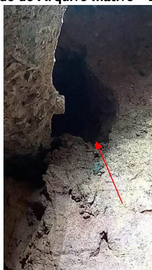
FOTO 51 – Subsolo ao lado do Arquivo Inativo – Erosão recente do terreno
