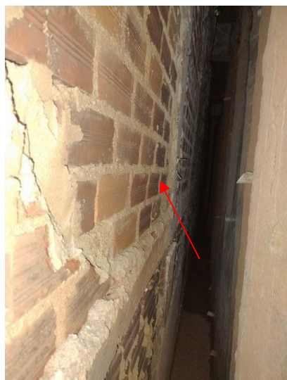
FOTO 43 – Subsolo sob a Rampa de Veículos – Alvenaria do subsolo s/ revestimento e impermeabilização
