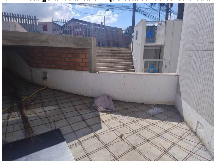
FOTO 02 – Vista geral da área em que está sendo construída a Guarita
