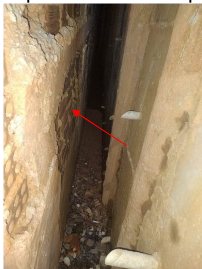
FOTO 42 – Subsolo sob a Rampa de Veículos – Alvenaria do subsolo s/ revestimento e impermeabilização
