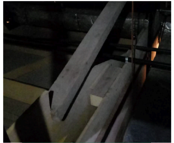
Escora de madeira improvisada
