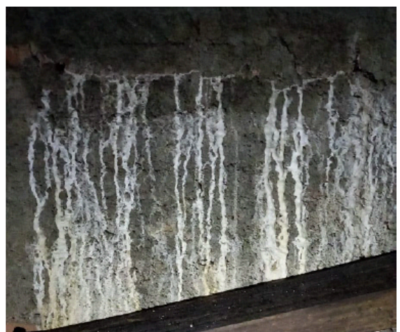
Eflorescência (umidade)
