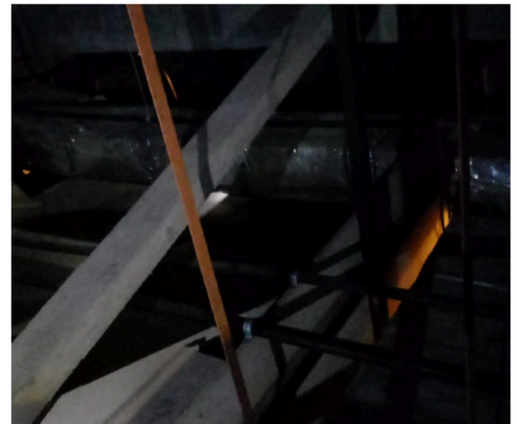
Escora de madeira improvisada
