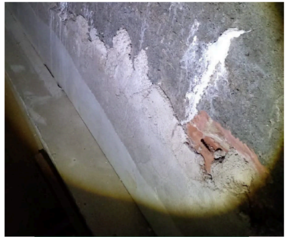
Eflorescência (umidade)
