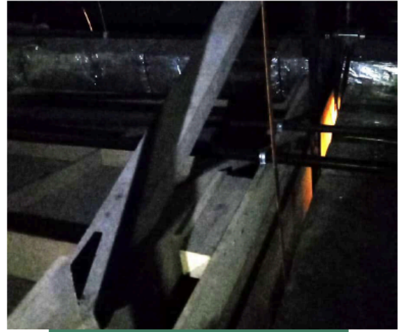
Escora de madeira improvisada
