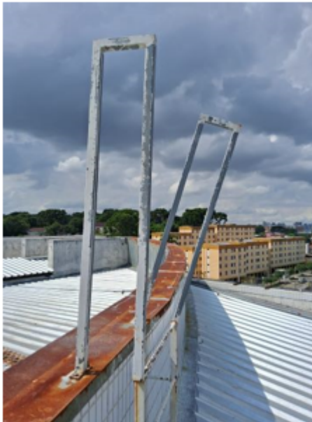
Escada acesso quebrada
