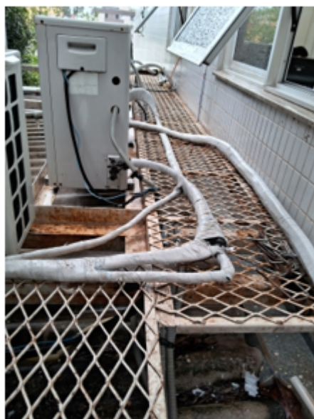
Plataforma instalada junto ao telhado
