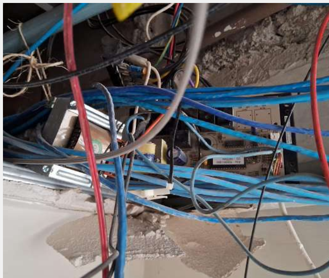
Rede de lógica, som e elétrica totalmente emaranhadas
