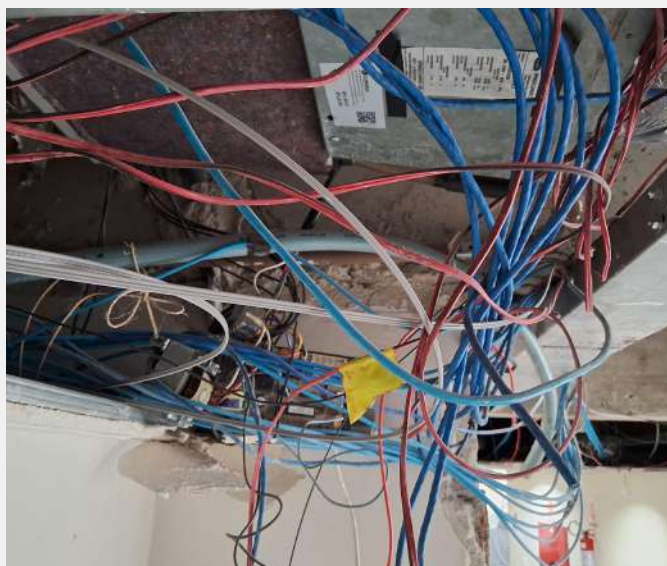
Fiação pendurada por barbante, solta e desorganizada
