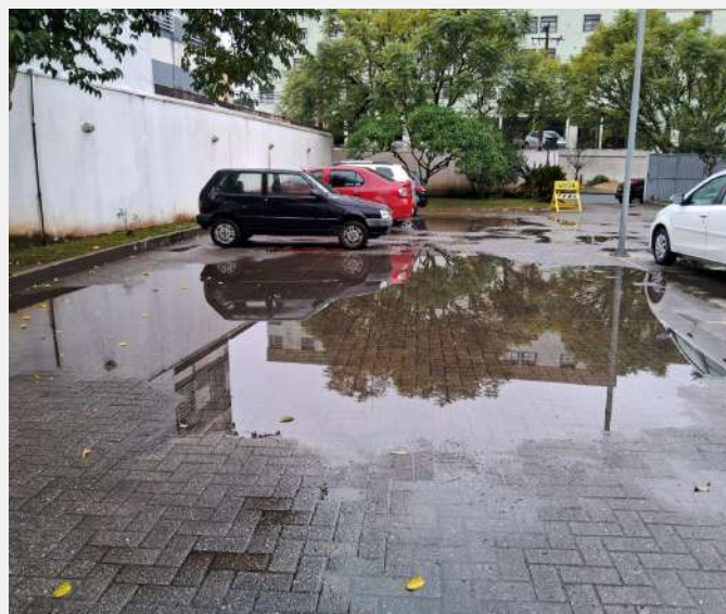
Estacionamento com extensas poças d'água
