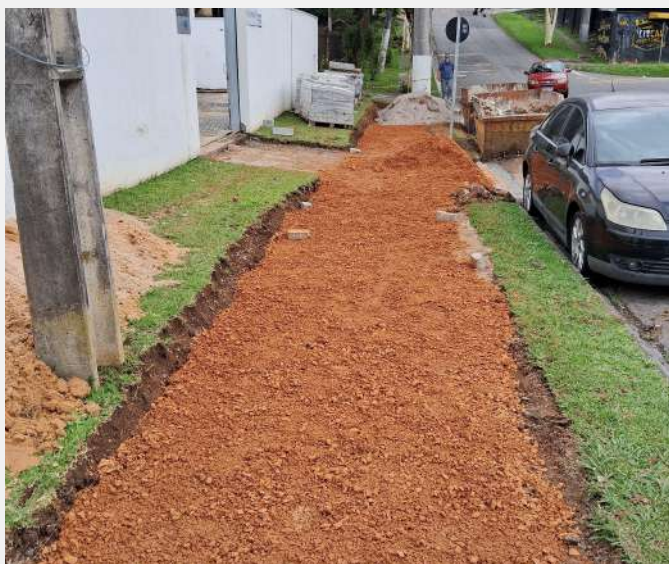
Preparação para nova calçada externa
