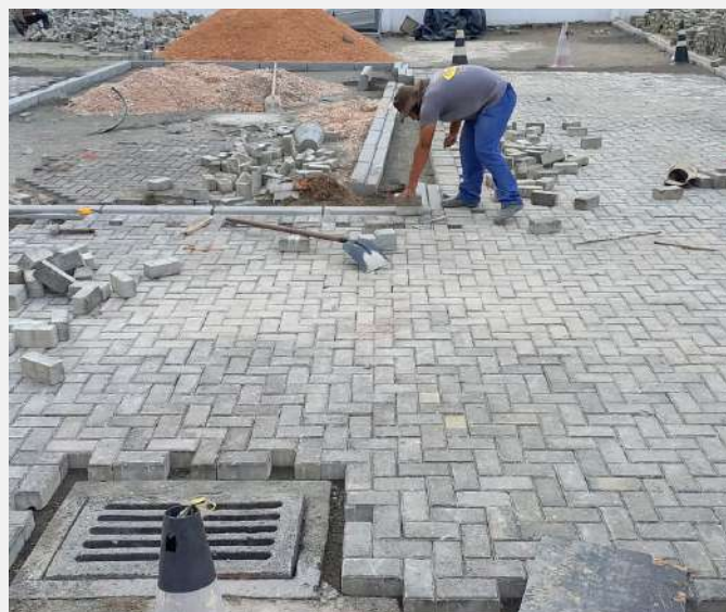
Readequação do sistema de drenagem e revisão da pavimentação com paver
