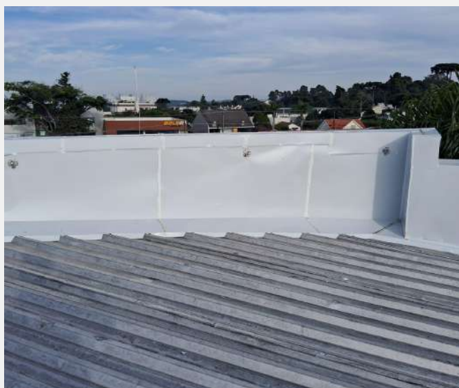
Correção das falhas, limpeza e recomposição das áreas afetadas
