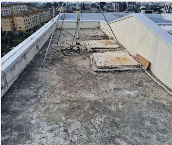
Laje e tampa das caixas d'água do prédio
