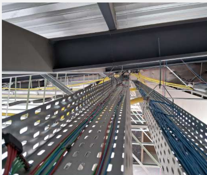
Execução de eletrocalhas dentro das normas com separação da elétrica e lógica
