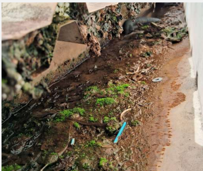
Calhas entupidas, com lama, sujeira e proliferação de musgos
