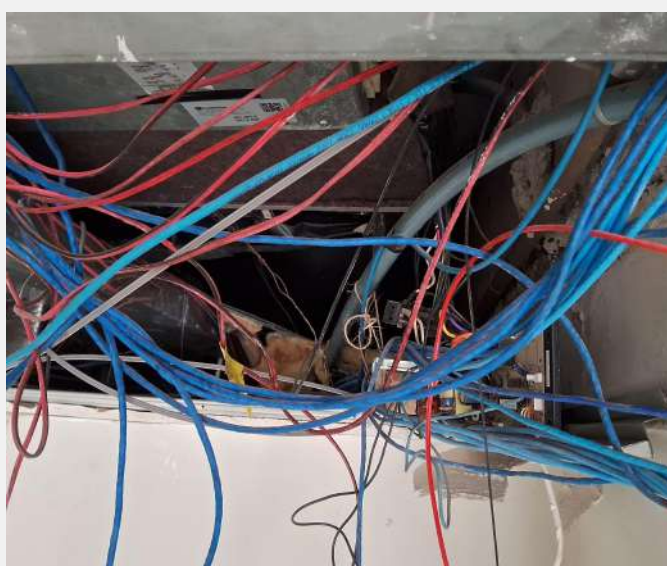
Fiação pendurada por um barbante, solta e desorganizada
