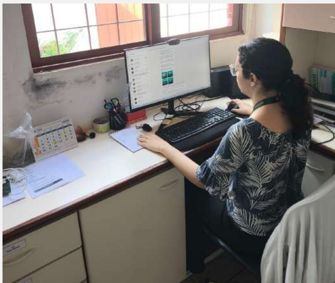
Parede com manchas de mofo e armário sem porta para a funcionária encaixar as pernas (sem mesa e ergonomia adequadas)
