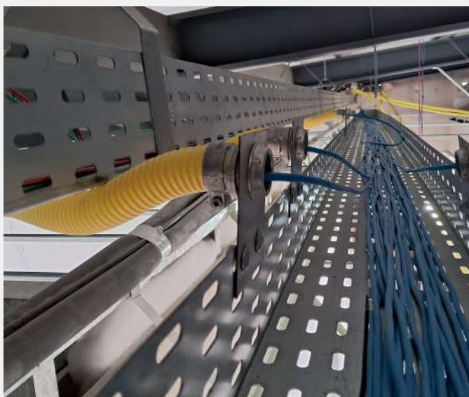
Correção das emendas e reorganização completa dos condutores com aplicação de calhas adequadas
