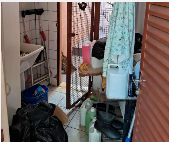
Área de serviço da regional utilizada como depósito e área de descarte
