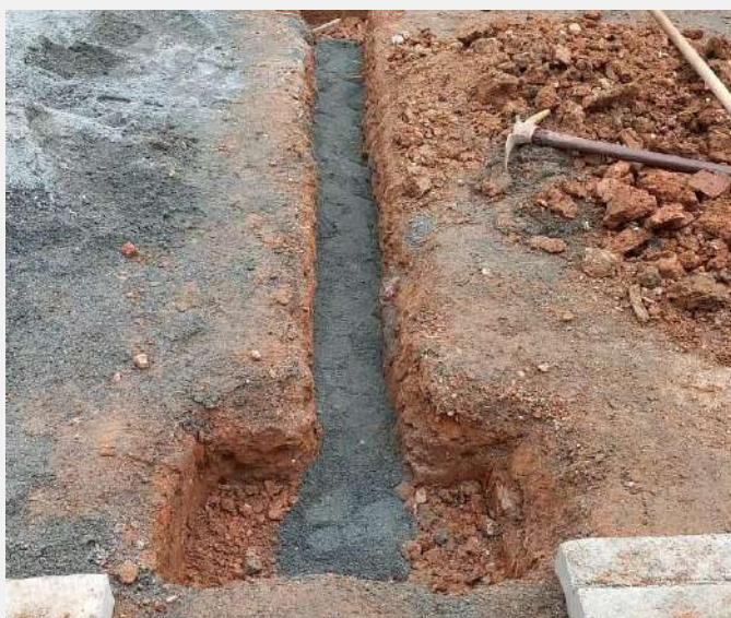
Execução de novo sistema de drenagem da pavimentação
