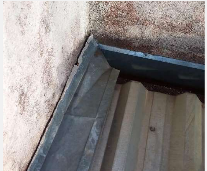
Calha soltando, com falhas na vedação
