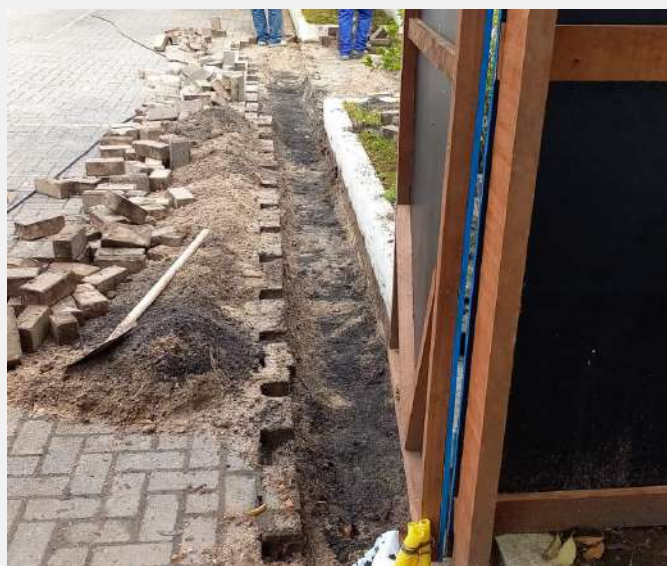
Abertura de drenos para solução de escoamento paver
