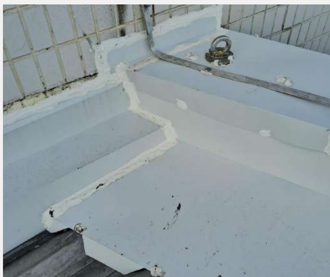
Reparo das fissuras, limpeza, reposição de estruturas e recomposição do revestimento
